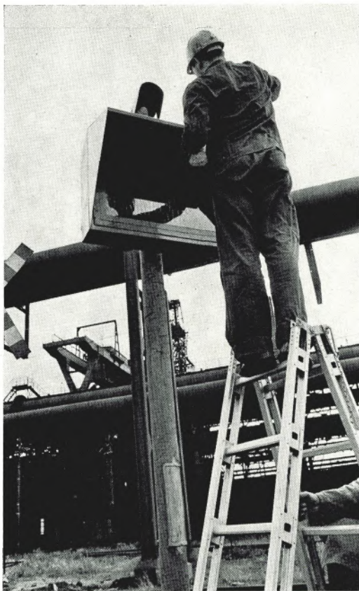
Auch hier geht es um die Sicherheit: An den Bahnübergängen warnen Hinweisschilder und Ampeln
