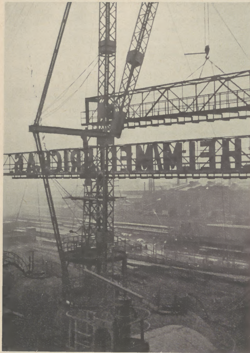
Der Derrickmast mit Ausleger und Fachwerkbrücke
