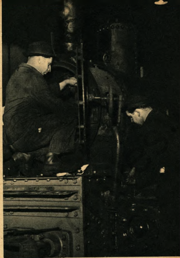
▲ Die Schlosser Kurt Haake und Fritz Brock montieren die Dampf-Ein- und -Ausströmrohre an einer Schmalspurlok in der Lokomotivwerkstatt
