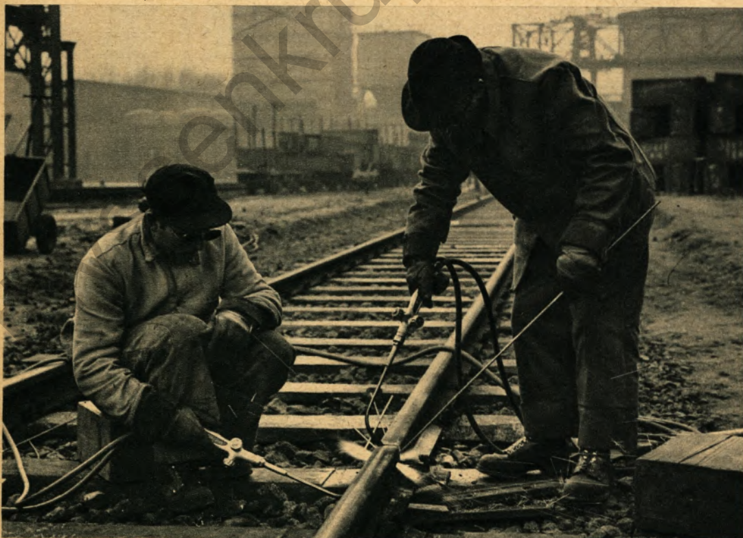
◀ Die Schweißer Josef Berlin und Otto Oehring beim Verschweißen der Schienenstöße
