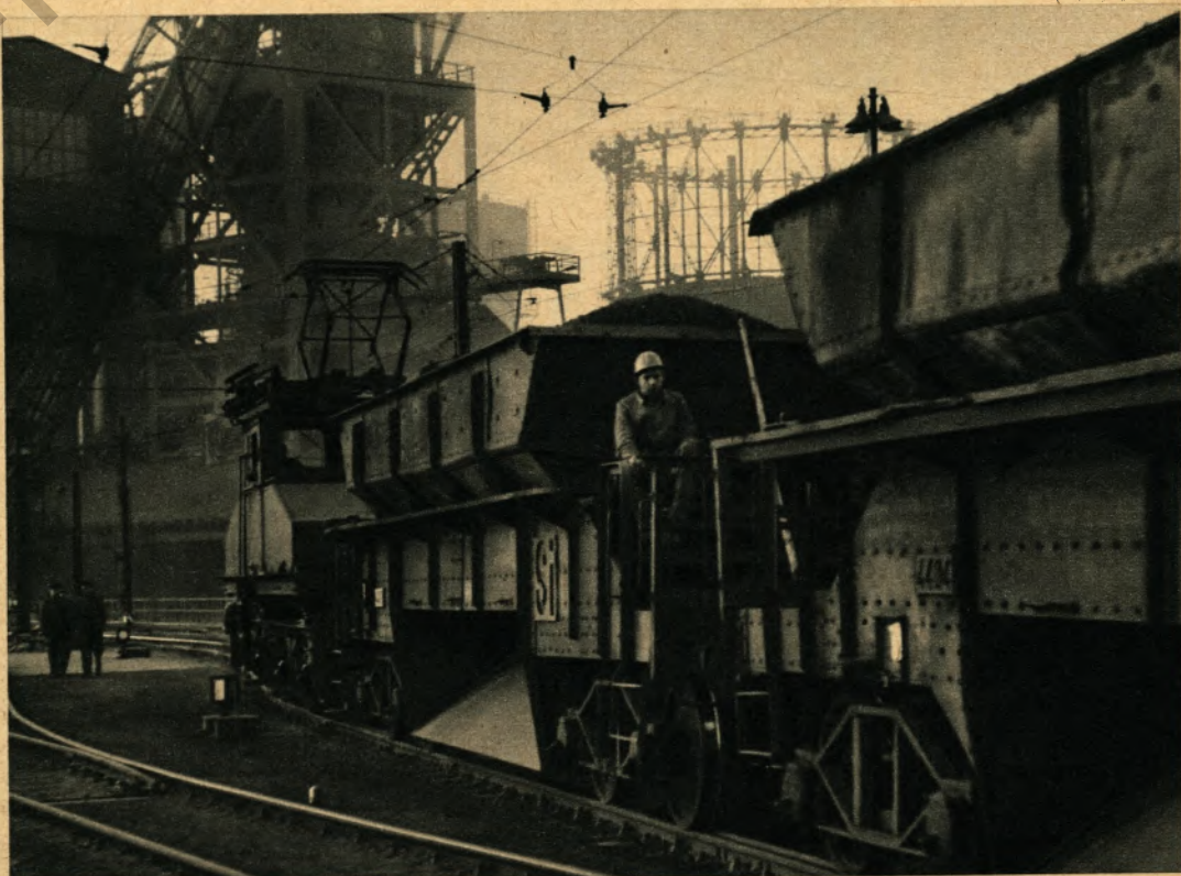
▼ Eine 700-PS-Elektrolok zieht mit Sinter gefüllte Selbstentladewagen zum Hochofen VI
