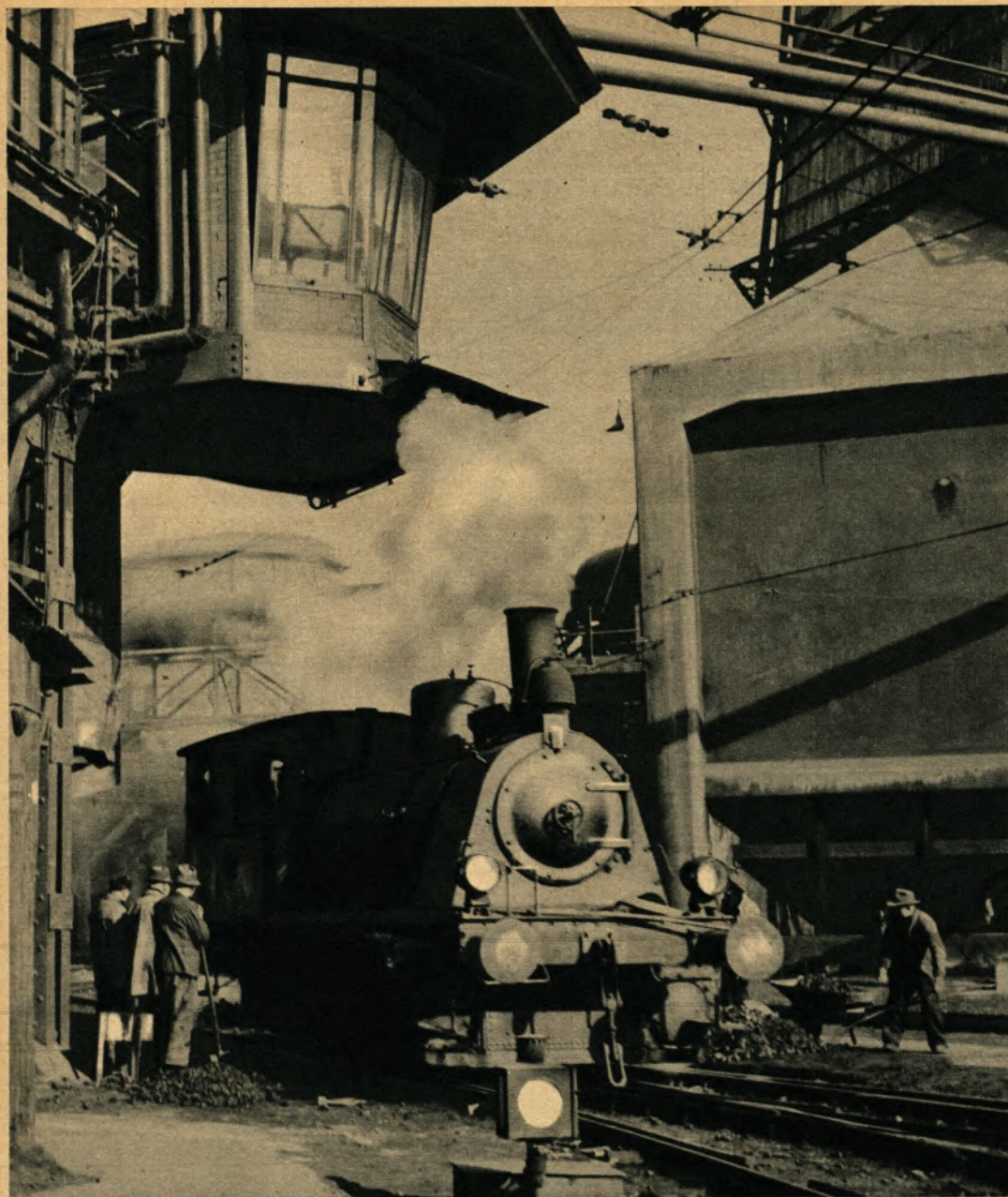
◀ Eine unserer 45 Jahre alten Dampfloks unter dem neuzeitlichen Stellwerk „Mischer“
