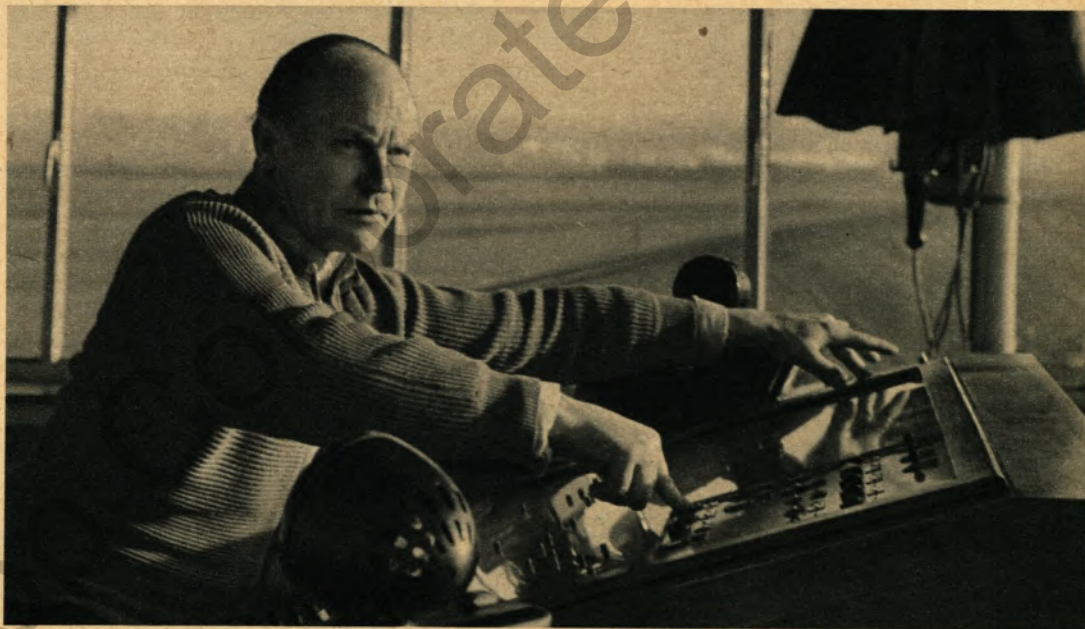
▲ Weichensteller Stülmeyer an seinem Arbeitsplatz im Stellwerk „Rüschelbrink“ am neuen SM-Werk. Im Vordergrund ist die Wechsellautsprecheranlage erkennbar, die der Verständigung mit den Nachbarstellwerken und den Rangiermeistern dient
