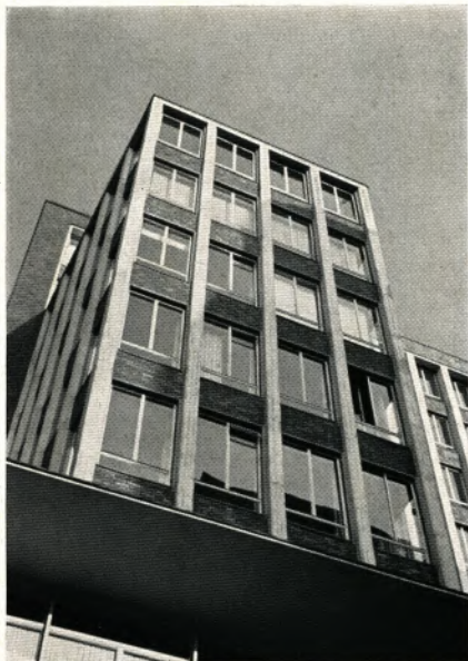
Stahlbetonskelettbauten prägen das Gesicht unserer neu entstehenden Städte. Diese Gebäude, wie sie auch die Westfalenhütte AG herstellt, werden unter weitgehender Verwendung von Torstahl und Baustahlgewebe errichtet (so auch der Neubau auf unserer Titelseite)
