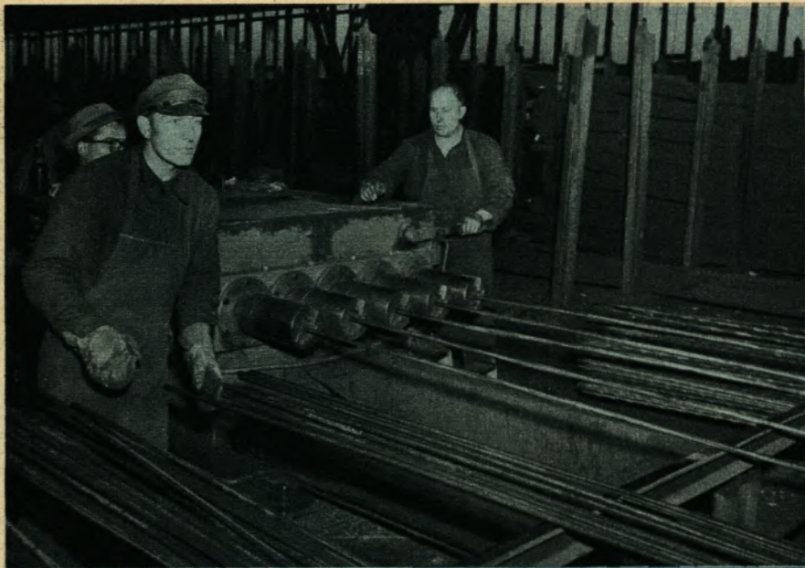
Drillköpfe einer fünfköpfigen Verwindemaschine.
