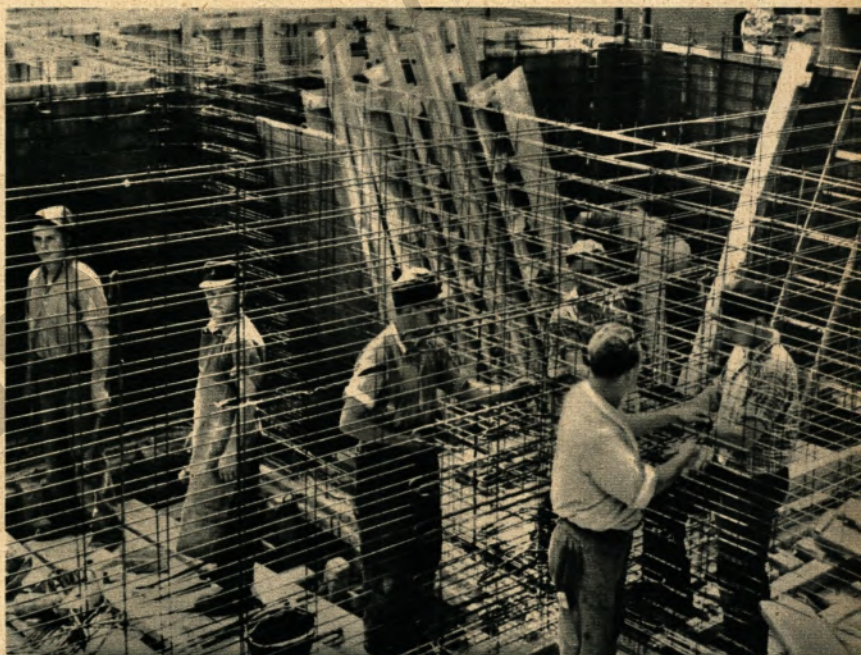
Hier wird Baustahlgewebe als Wandbewehrung für einen Getreidespeicher verwendet.
