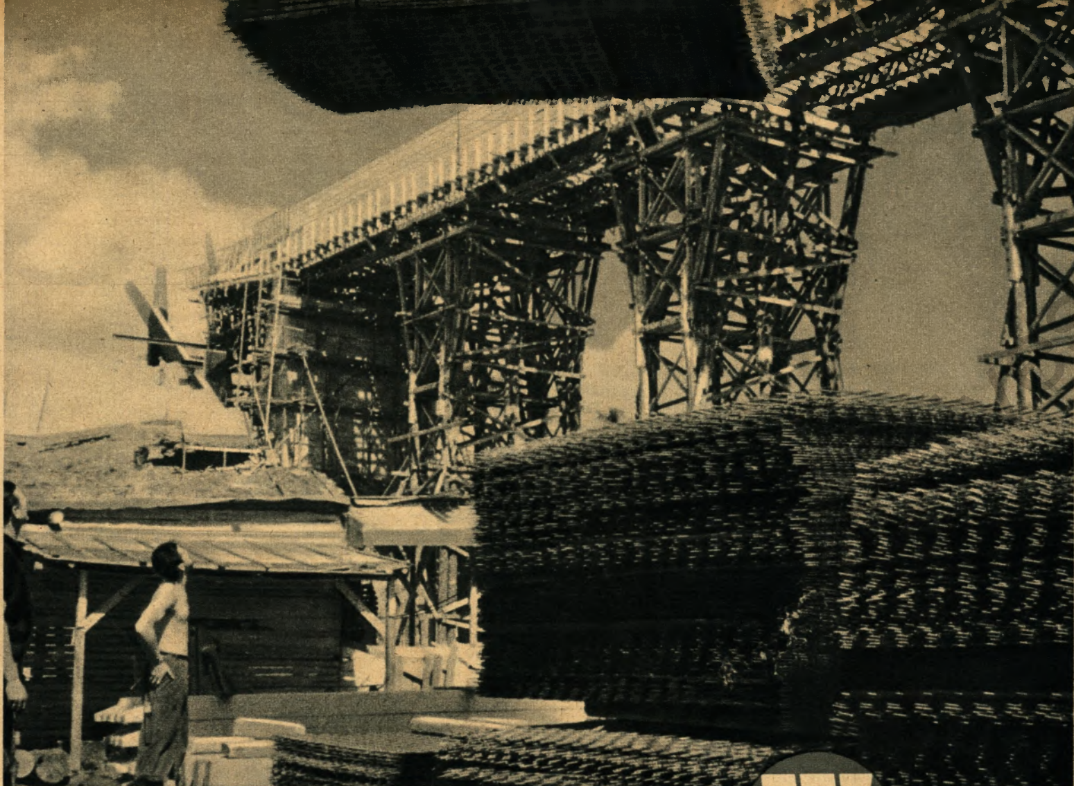
Auch im Brückenbau hat das Baustahlgewebe — „ein Baustoff der Zukunft“ — große Bedeutung erlangt.
