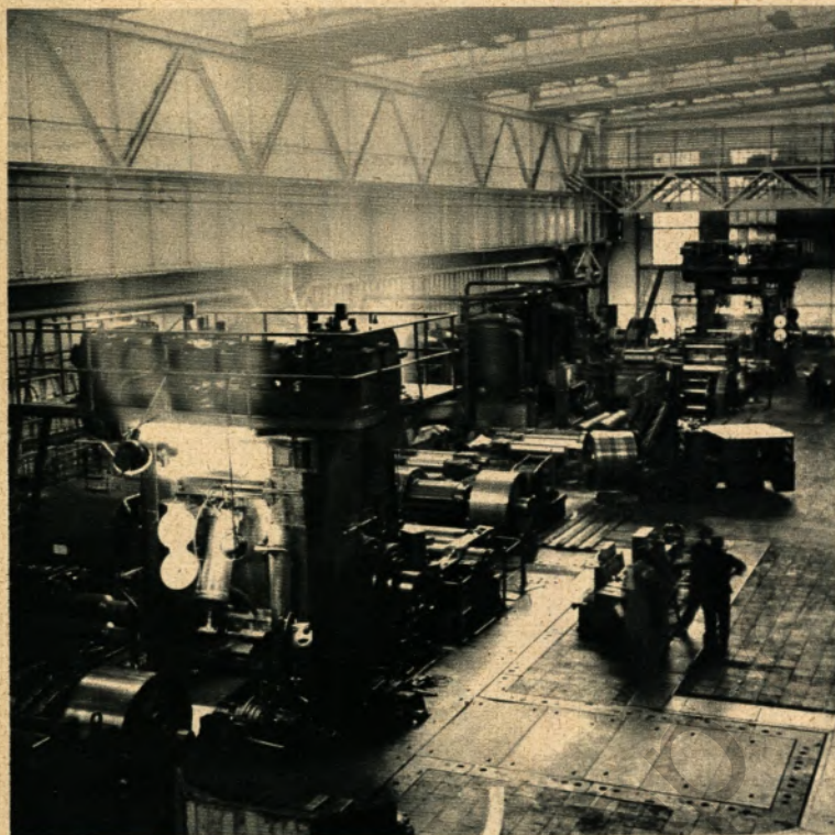
Das Kaltwalzwerk ist nach den modernsten Erkenntnissen wieder aufgebaut.
