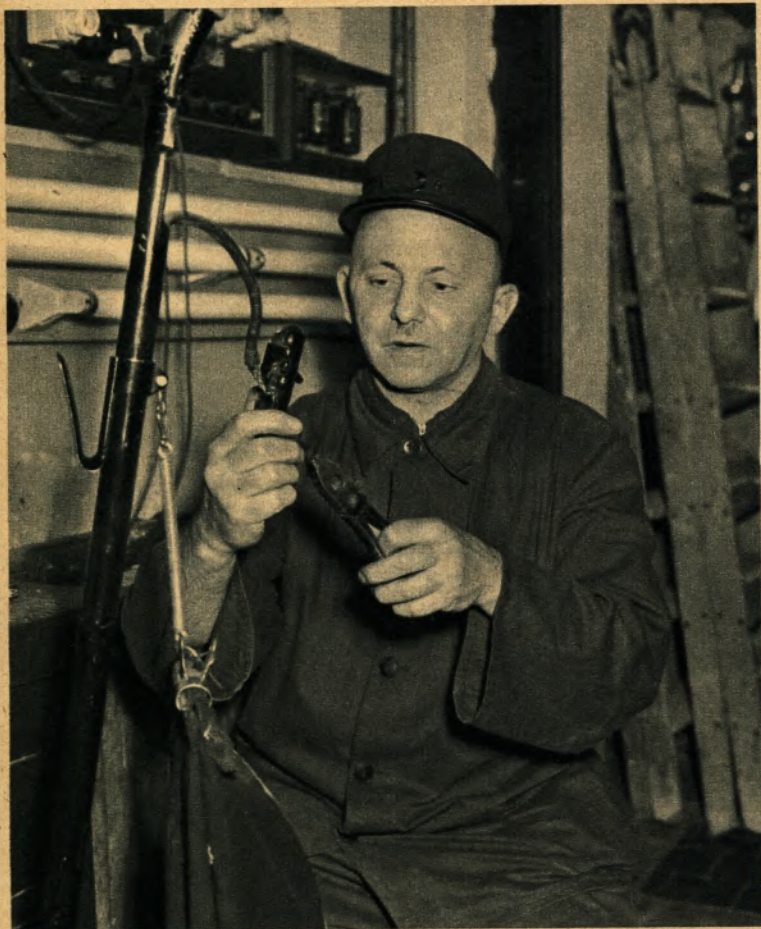
Es werde Licht ist die Devise von Alfred Mevissen, Elektriker in der Abteilung Bauwesen. Hier ist er gerade dabei, eine Schalttafel zu montieren.
