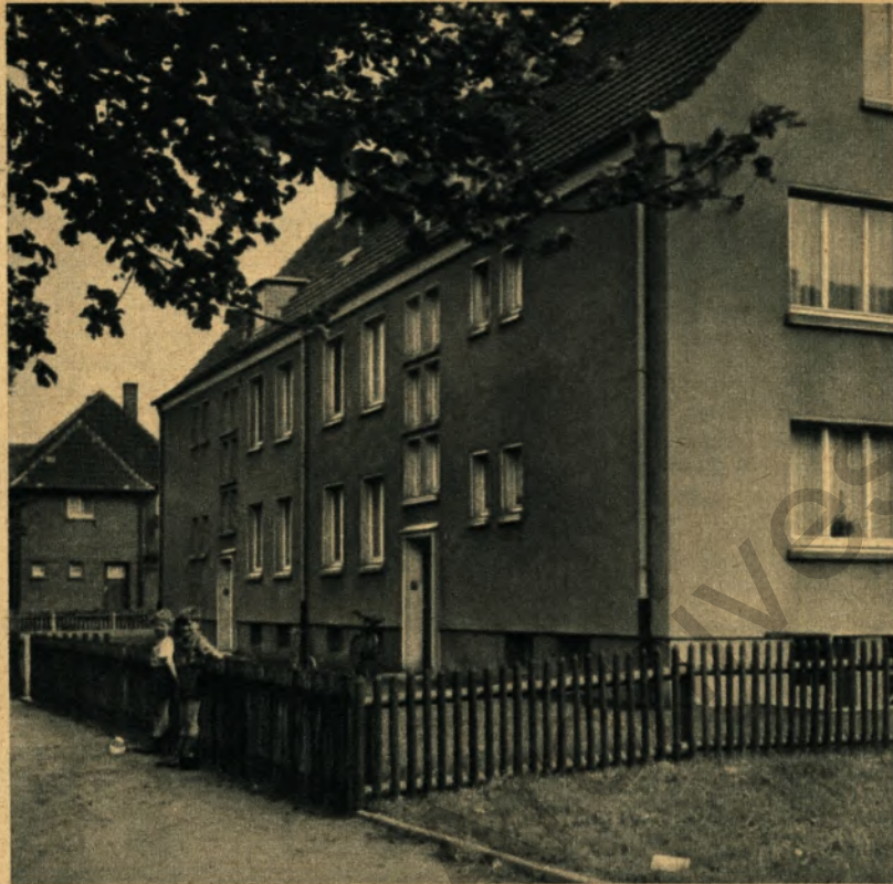
Aber nicht nur da, wo der Krieg Lücken schlug, wurde neu aufgebaut, sondern auch da, wo bisher keine Häuser standen. Ganz neue Siedlungen wurden geschaffen. Ein Haus in Hervest-Dorsten, Glückaufstraße.
