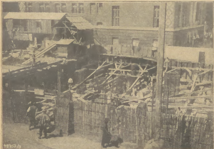
Bild 1: Die Baugrube im Juni 1932. Im Hintergrund sind die Larsseneisen deutlich erkennbar
