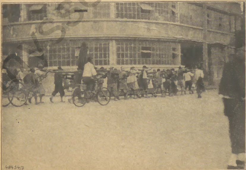
Bild 3: Die einzelnen Konstruktionsteile werden von den chinesischen Arbeitern mit Hilfe von Bambusstäben zur Baustelle gebracht
