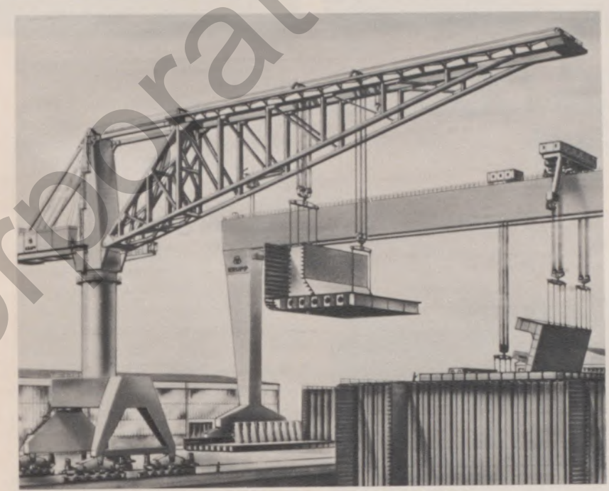
▼ So wird der 60 Meter hohe Kran – er besitzt eine Hubkraft von 200 Tonnen – mit seinem 75 Meter langen Ausleger aussehen
