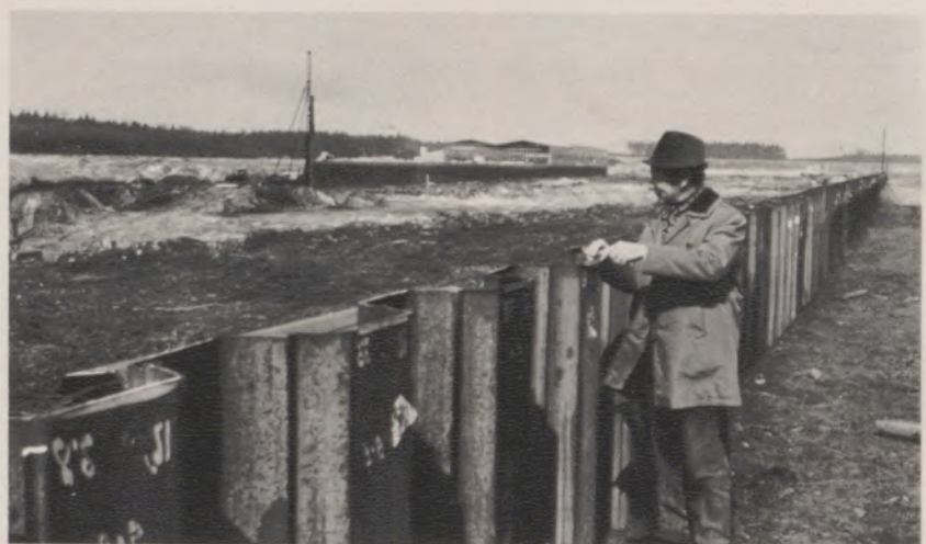
► Günter Reinicke vom Tiefbauamt Lüneburg inspiziert die fertig gerammte Uferspundwand
