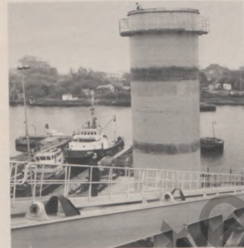
◄▼ Wie eine Manschette liegt das Rothe Erde-Lager auf dem oberen Rand dieses 28 Meter hohen Teilstückes des insgesamt mehr als doppelt so hohen Kranturmes
