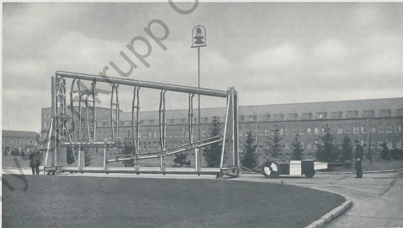
Transport einer Flügelbauvorrichtung
