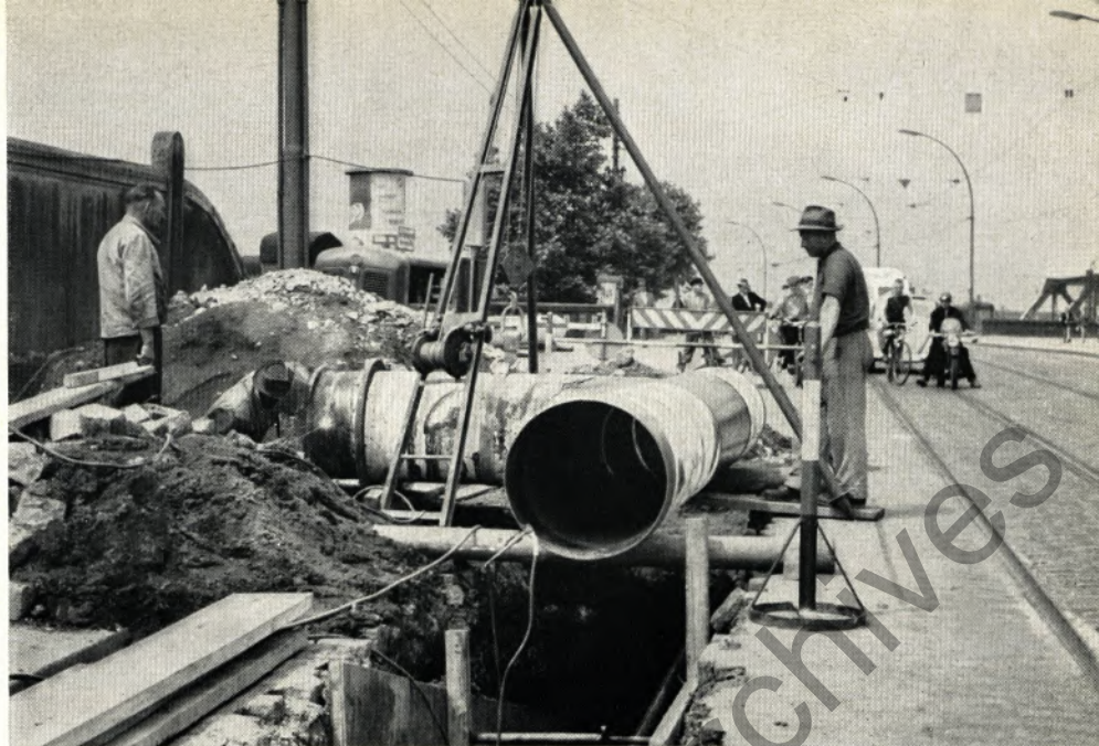
Für den Straßenpassanten ein vertrautes Bild: Auf verkehrsreicher Straße wird ein Rohrstrang verlegt
