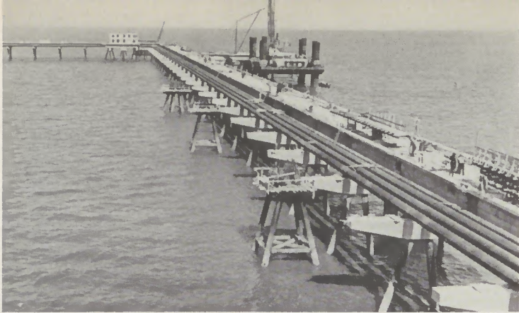
Löschbrücke der Rohrleitungen 30" der NWO Wilhelmshaven
