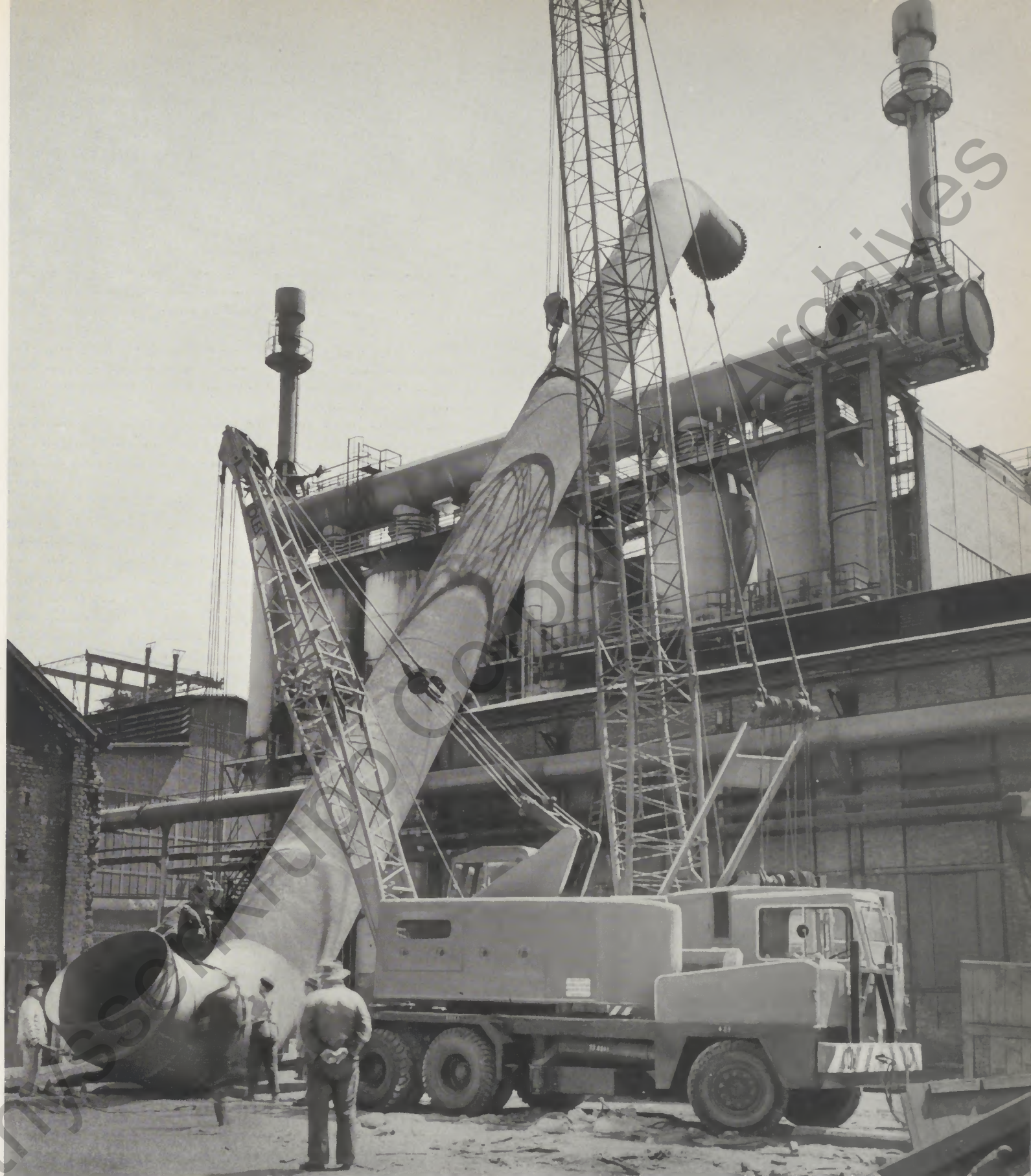
Hubert Schulte G. m. b. H. · Anschluß einer Gichtgasleitung · Ruhrstahl A. G.
