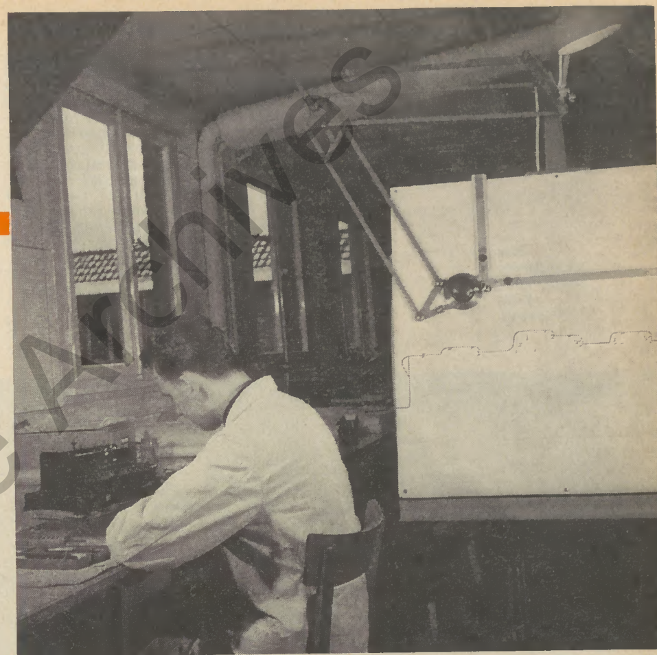
Das ist der zukünftige Arbeitsplatz des Drehers. Aus der Zeichnung des Werkstückes entnimmt er die einzelnen Wegpositionen für das Werkzeug und trägt sie in sein Programmblatt ein.
