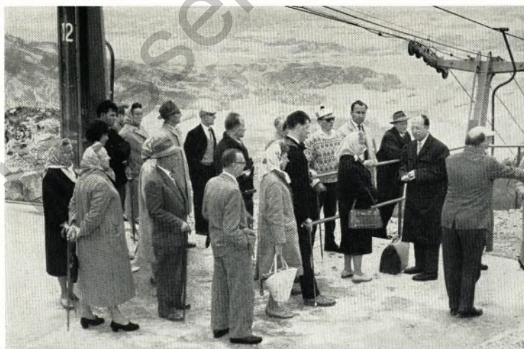
Von der Bergstation des neuen Sessellifts, der das Skigebiet Rossleiten erschlossen hat, bietet sich ein überwältigender Blick über den Chiemgau und die Autobahn München—Salzburg hinweg zum Inntal oder zu dem Land um den Chiemsee.
