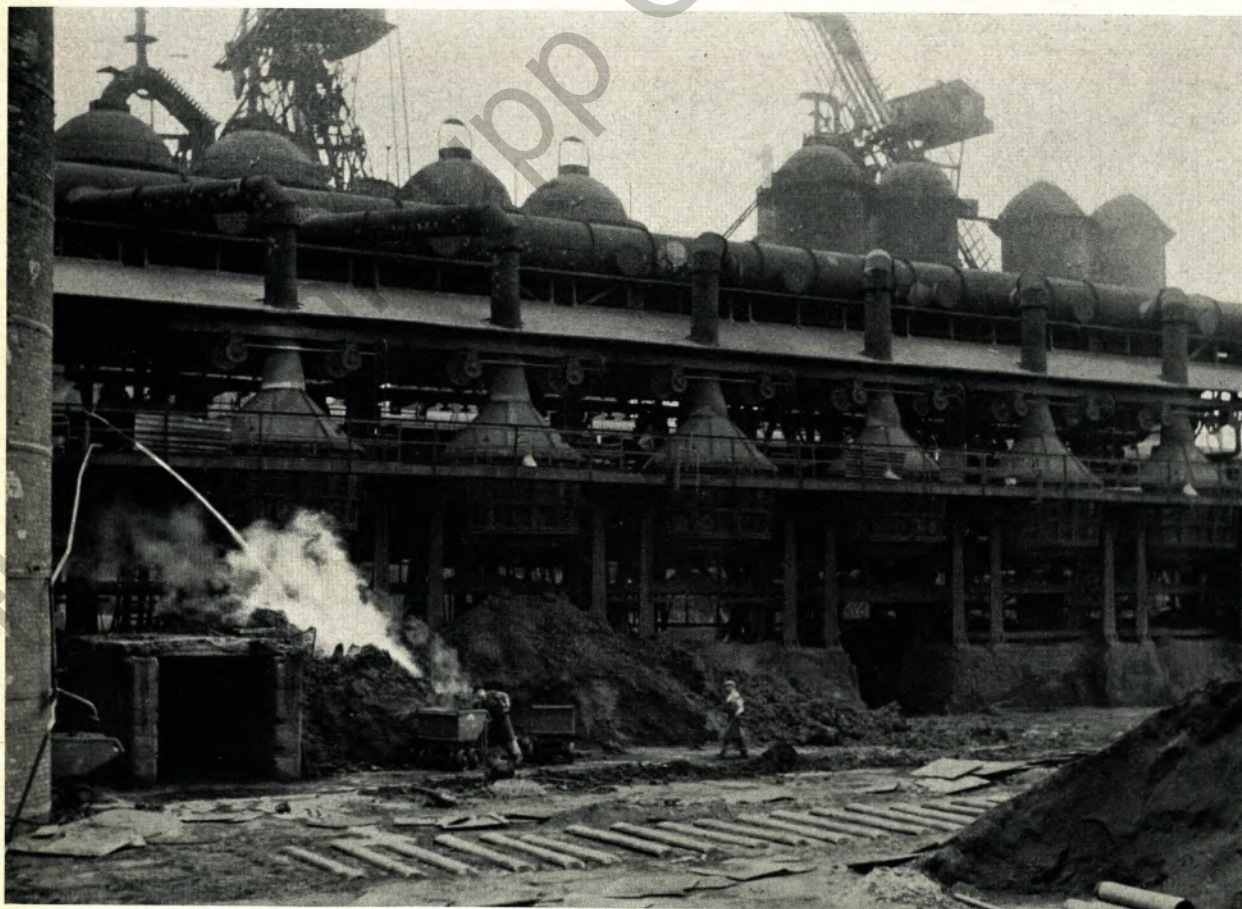
Die Röstanlage der Niederrheinischen Hütte, wie sie von 1913 bis 1957 in Betrieb war.
