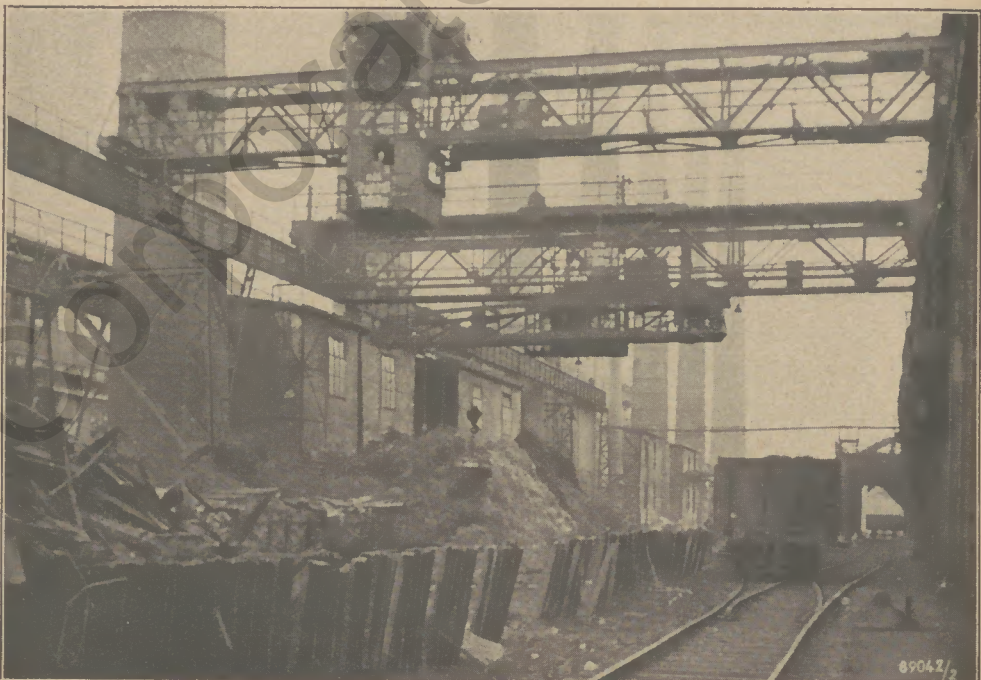
Magnet-Krane für Schrottverladungen am Stahlwerk
