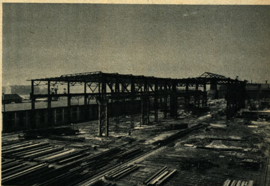
Anfang Juni waren die Hallen des 2. Bauabschnittes mit 1500 Tonnen Eisenkonstruktion (unser Bild) montiert.
