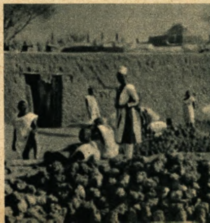
Bild unten: Trocknen von „Tonziegeln“ in Kano, Nigeria. Im alten Ägypten und Babylon wurden schon vor 5000 Jahren rechteckige Ziegel gestrichen. Bei der absoluten Trockenheit brauchen sie nicht gebrannt zu werden.
