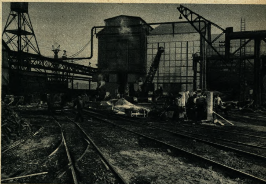
Dieses Bild zeigt, wie schwierig es war, bei Baubeginn eine geordnete Rohstoffversorgung für das Blechwalzwerk I/II sowie für die Walzendreherei über den Bauplatz zu sichern.
