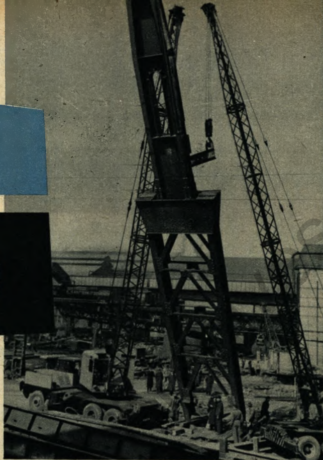
Mit Hilfe von zwei neuartigen amerikanischen Autokranen wurden in 10 Tagen 600 Tonnen Hallenkonstruktionen aufgestellt. Der Bau schreitet rüstig fort.
