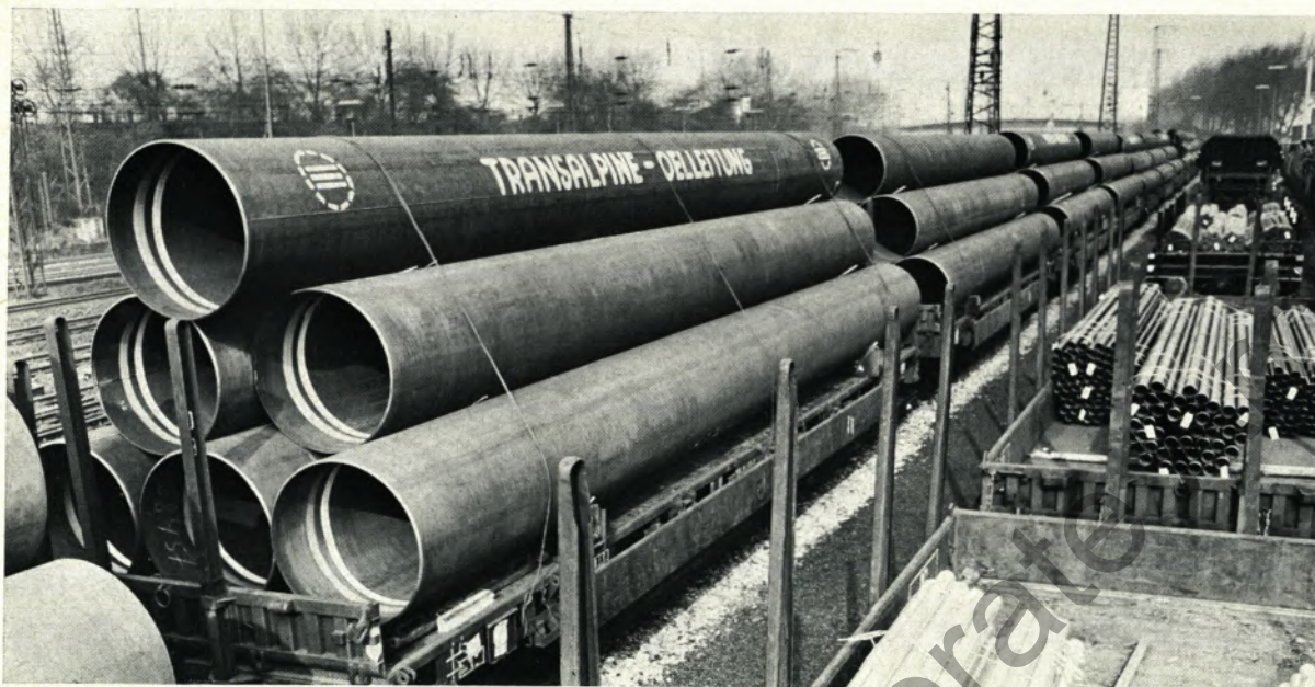
Großrohre von 1 m Durchmesser für die Transalpine Ölleitung von Triest nach Ingolstadt aus unserem Werk Mülheim im Bahnhof Styrum.
