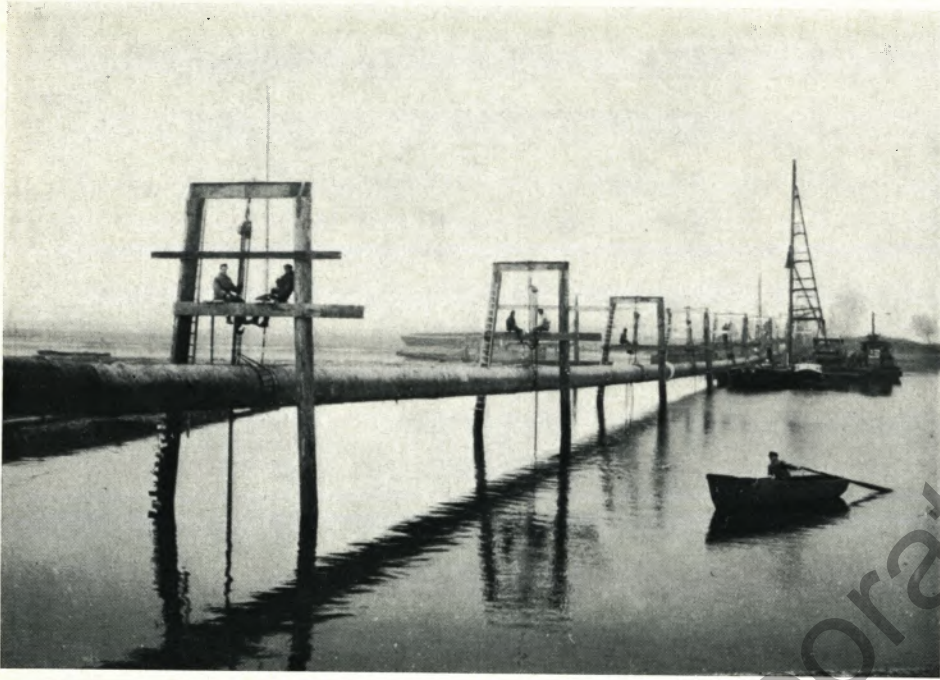
Gerüstabsenkungsmethode bei einem Düker durch die Süderelbe in Hamburg 1955.
