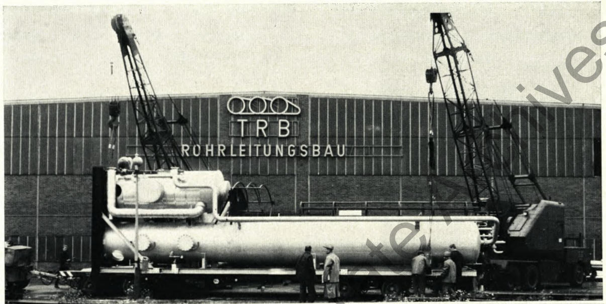
Eine auf Grundrahmen montierte Kolonne muß wegen ihrer großen Abmessungen vor der Werkshalle auf Tief-lader gesetzt werden.
