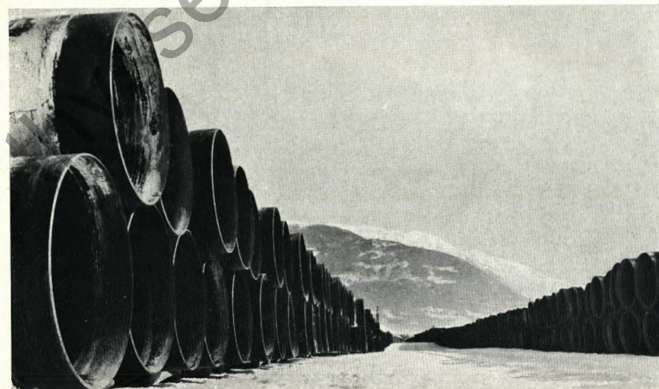
Hoch in den Alpen mußten die Großrohre gelagert werden, die wir für die Transalpine Ölleitung lieferten. Seite 20
