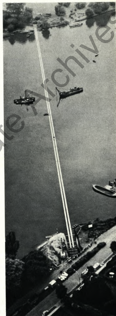
← Absenkungsschema für den Kahlbrand-Dükler im Hamburger Hafen 1958 nach dem Klappverfahren.
