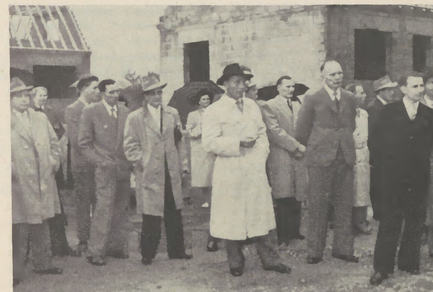
Oben: Eines der richtfertigen Häuser wurde mit dem Richtkranz geschmückt
