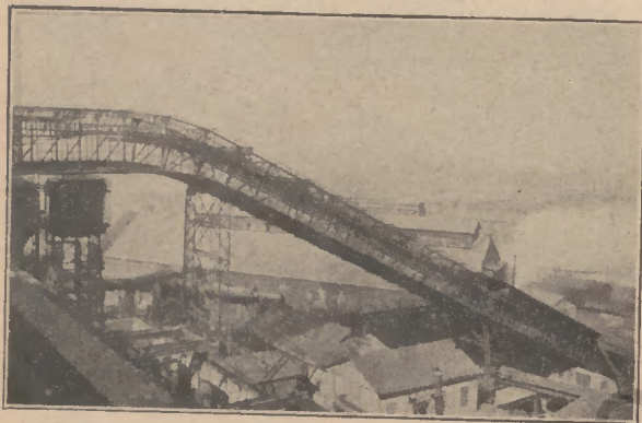
Schrägaufzug einer modernen Hochofenanlage.
