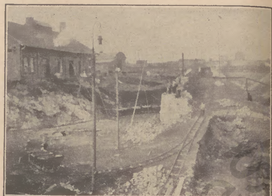
Aufnahme von den Ausschachtungsarbeiten beim Hochofenneubau 1899.
