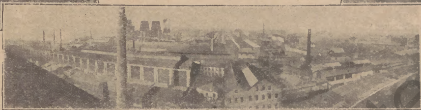
Heutige Gesamtansicht der Werksanlagen.
