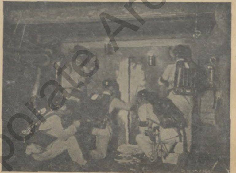
Schießen eines Brandbereitschaftsdammes im Pechhammerflöz auf Seche „Königin Luise“. Die Sprengkolonne ist mit Dräger-Bergbaugeräten ausgerüstet.
