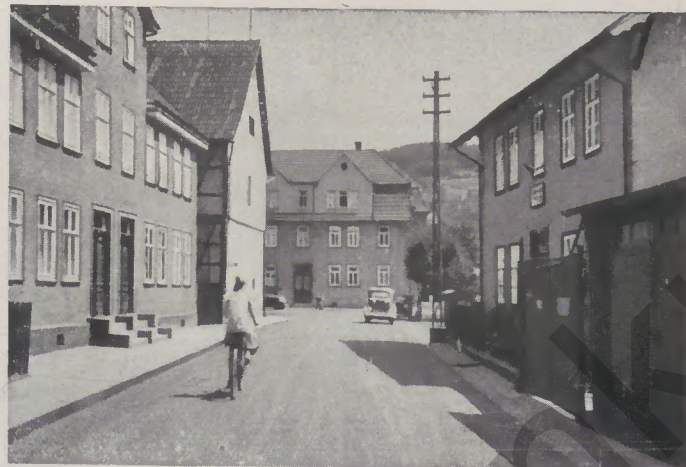
Teerplatteppich als neuzeitliche Befestigung einer Gemeindefraße
