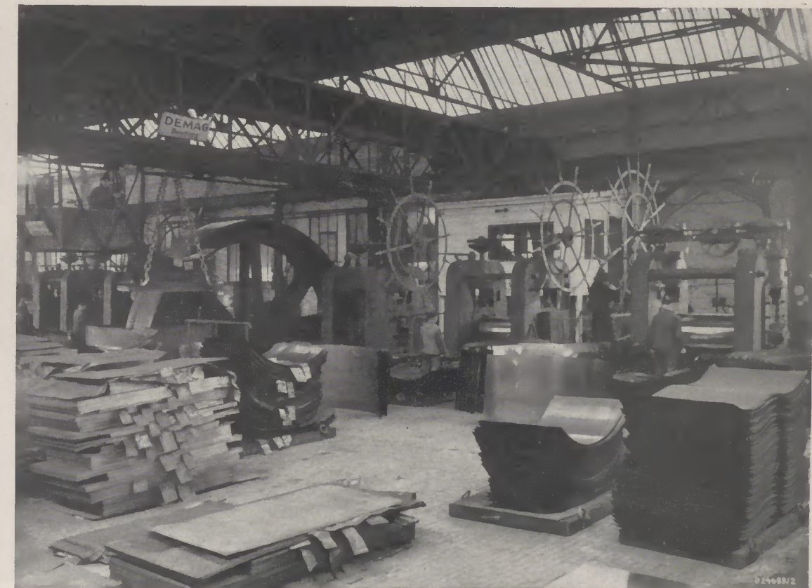
Kaltwalzen und Dreihieren der Karosseriebleche
