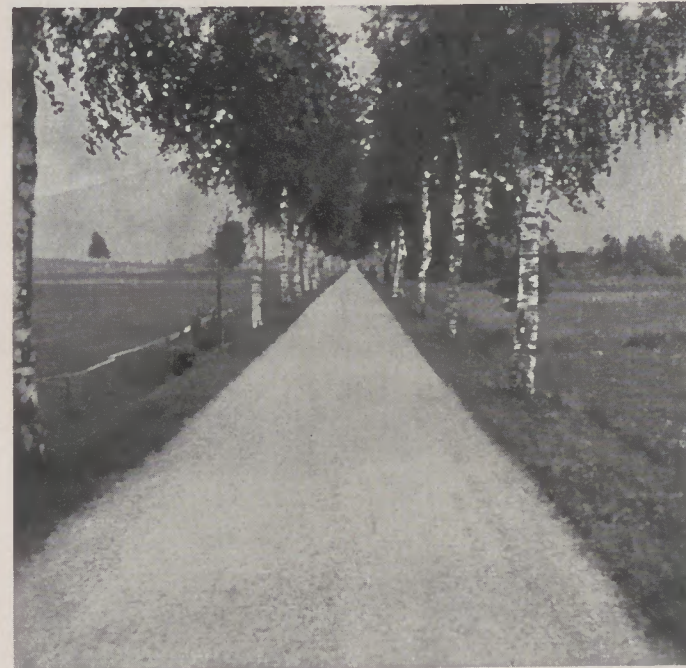
Oberflächenteerung einer Straße im Borsalpengebiet
