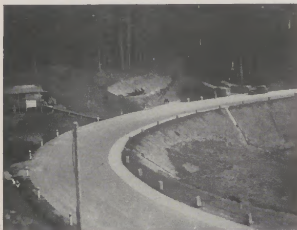
Teerbeton auf einer Straße im Schwarzwald
