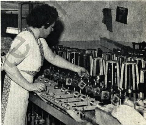
Spulerin Otilie Milde reguliert die Verlegung des Feinstdrahtes.
