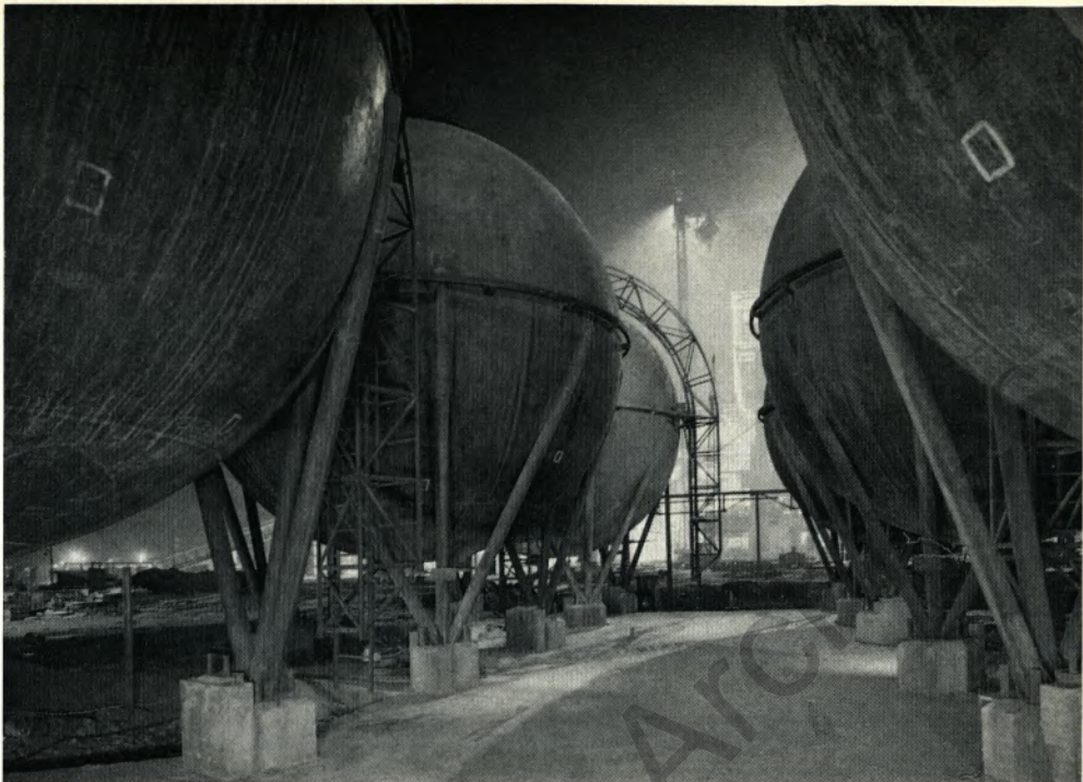
Die mit Phoenix-Union-Elektroden geschweißte Kugelgasbehälterbatterie der August Thyssen-Hütte in Duisburg-Hamborn.
