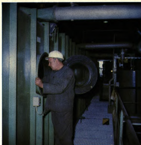
Bild links: Beizer Philipp Sprenger am Beobachtungsfenster eines Beizbades. Bild rechts: Die alte Beize im Werk Lippstadt. In dieser „Waschküche“ voller Dämpfe wurde bisher gearbeitet. Im Bild sieht man Beizer Bernhard Linnemann, der gerade einen Drahtbund in das heiße Nachbehandlungsbad eintaucht. Die alte Anlage ist bereits demontiert, das Gebäude wird einer anderen Nutzung zugeführt.
