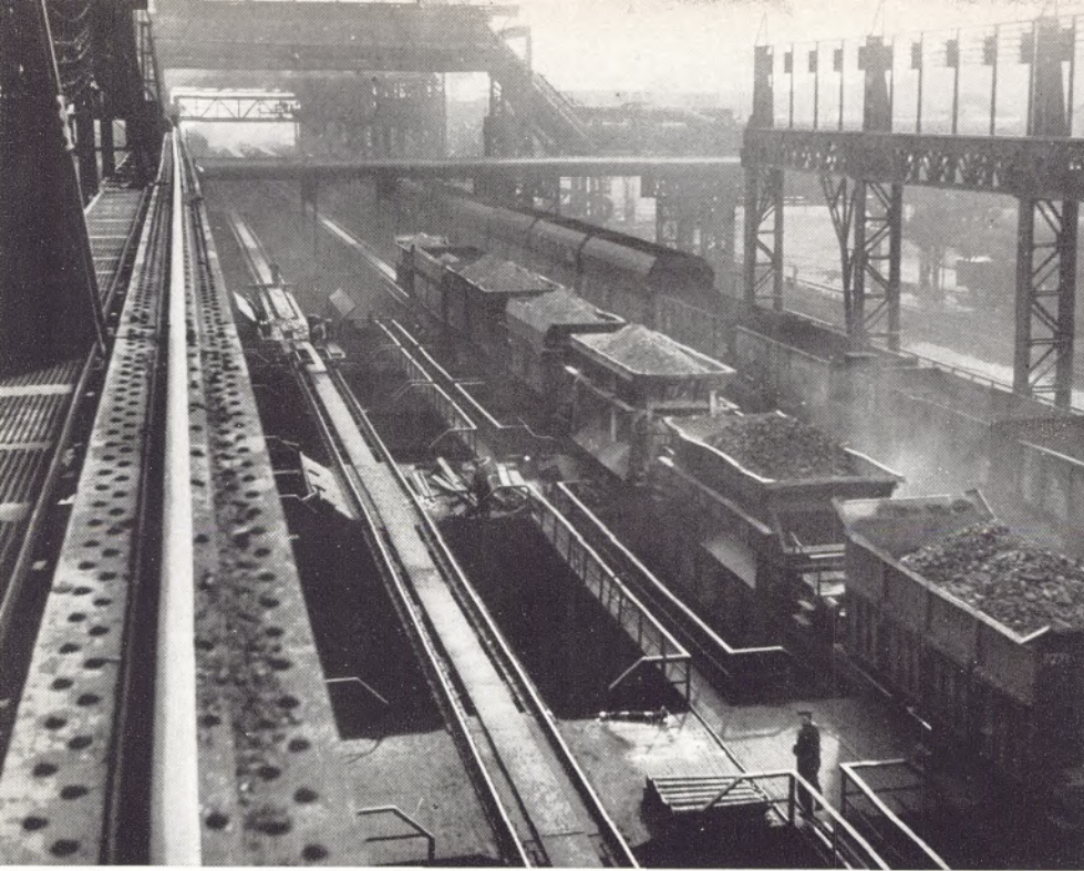
Auf der Hochbahn hinter den Hochöfen unserer Hütte. Unter den Gleisen die Bunker mit Erzen aus aller Welt, die hier zur Beschickung der Hochöfen gelagert werden
