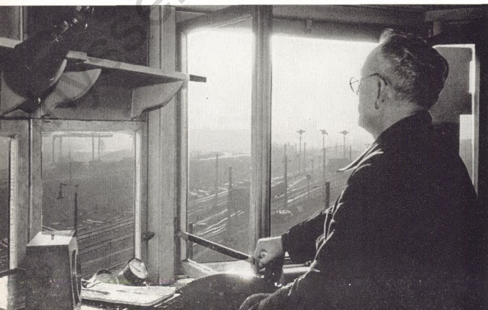
Der alte Bremsenturm für die Thyssen-Gleisbremse neben dem Ablaufberg am Betriebsbahnhof Grünstraße. Im Keller die Pumpanlage, im Pavillon an der Turmspitze die Bremssteuerung für die Gleisbremse unterhalb des Ablaufberges. Bremsmeister Arthur Thomas (unteres Bild) gehört zu den alten, erprobten Hasen; im vergangenen Jahr war er vierzig Jahre im Dienst!
