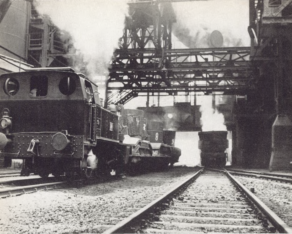
Schlacken- und Roheisen-Transportwagen gehören zu den wichtigen Spezialfahrzeugen im Hüttenbetrieb. Hier kommt es auf höchste Zuverlässigkeit und Sicherheit, auf ein tadelloses Zusammenspiel der Hochöfner mit den Männern von der Schiene und auf den Loks an. Ein Bild vom Roheisen-transport im Hüttenbetrieb der ATH, rechts ein Transportwagen für Schlacke
