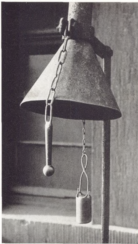
Rohrpost vom Bahngelände zum Steuerstand im Bremsturm am Bahnhof Grünstraße. Zwar ist diese Einrichtung schon recht bejahrt. Aber ihre Stabilität ist unversehrt. Sie bewährt sich heute wie ehemals bei der Übermittlung schriftlicher Anweisungen an die Bremsmeister
