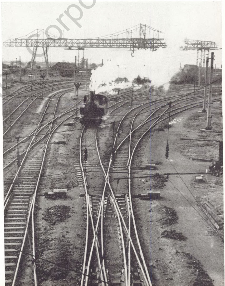
Werkshafen Schwelgern der ATH: ein Bild, das einen Eindruck vom Umfang und der Vielfalt der Verkehrsanlagen vermittelt
