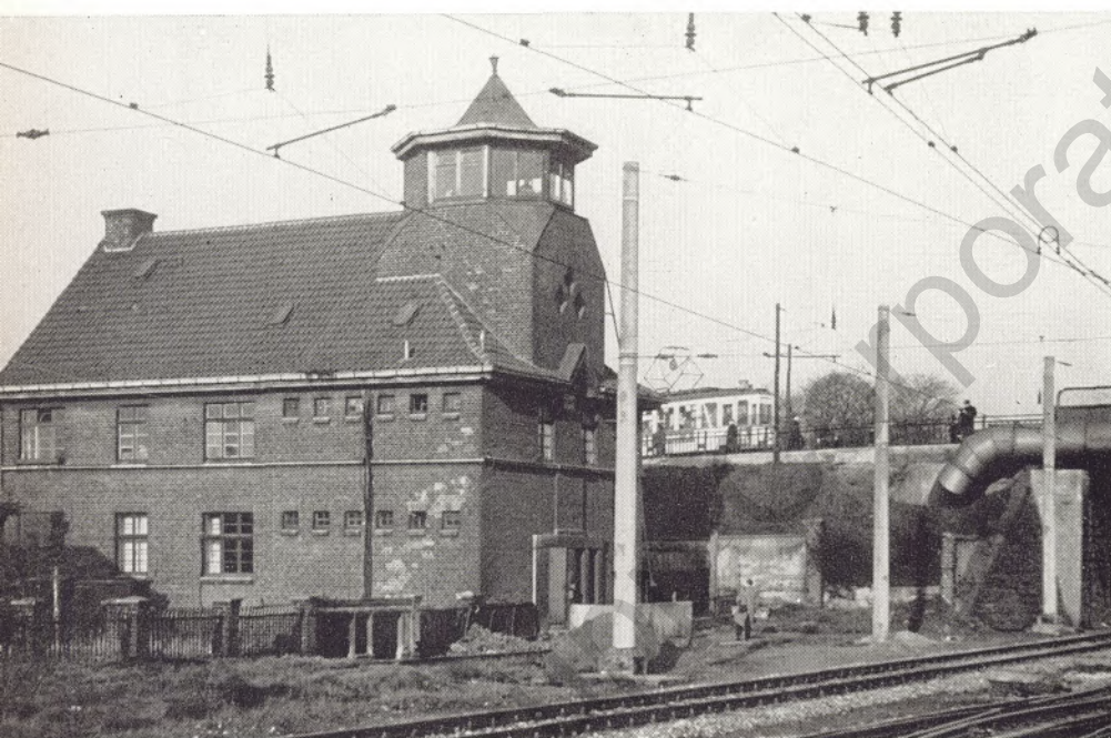
Der alte Bremsenturm für die Thyssen-Gleisbremse neben dem Ablaufberg am Betriebsbahnhof Grünstraße. Im Keller die Pumpanlage, im Pavillon an der Turmspitze die Bremssteuerung für die Gleisbremse unterhalb des Ablaufberges. Bremsmeister Arthur Thomas (unteres Bild) gehört zu den alten, erprobten Hasen; im vergangenen Jahr war er vierzig Jahre im Dienst!
