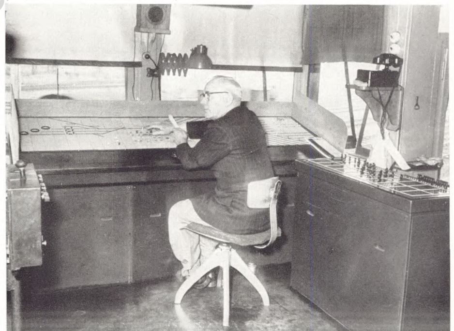
Stellwerk Grünstraße besitzt eine moderne Gleisbildanlage mit Fahrtenspeicher (rechts)
