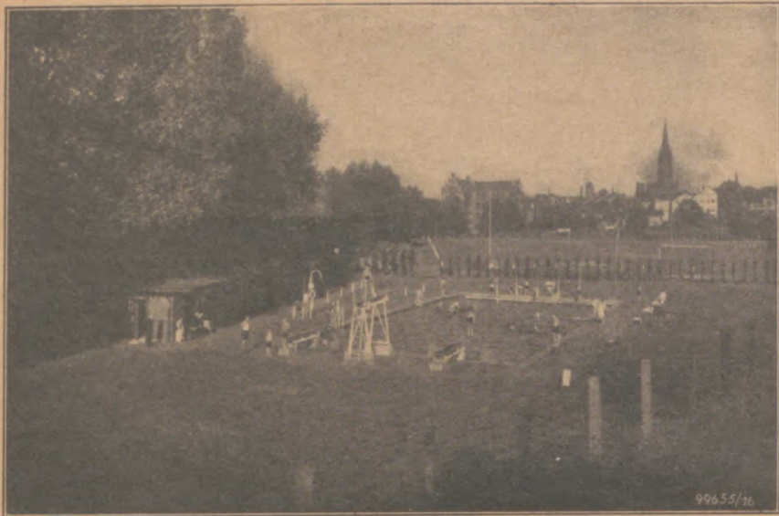
Schwimm- und Heilbad, Werk Hörde
