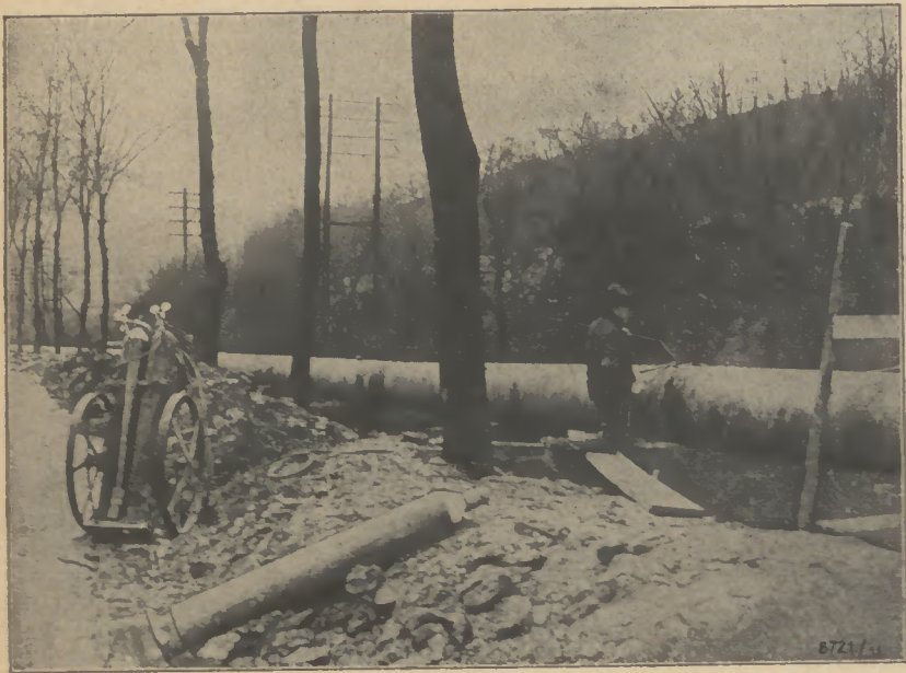
Schweißarbeit auf der Strecke Die einzelnen Rohrstücke werden mit der Klöppermuffe untereinander gasdicht verbunden. Autogenschweißer bei der Arbeit
