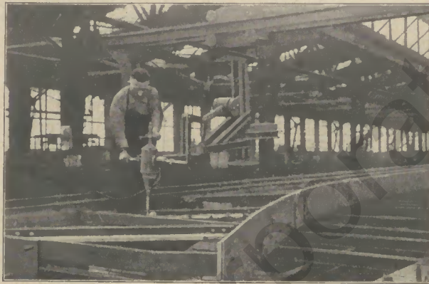
Bild 8: Aufreiben von Nietlöchern
