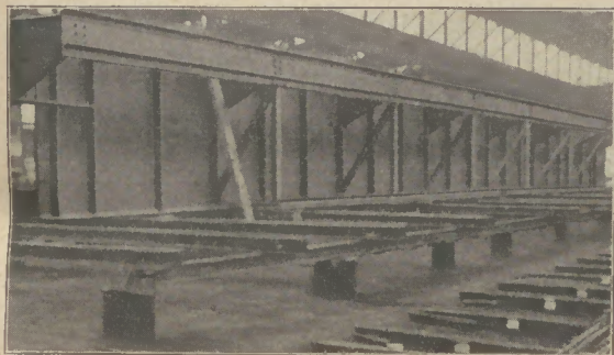
Bild 10: Geschweißter Träger der Allerbrücke Verden auf der Zusammenbauzulage
