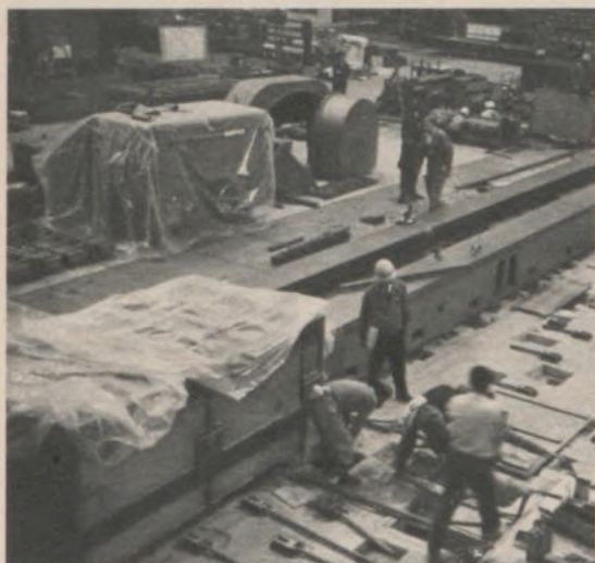
1 Vorbereiten des Fundaments
