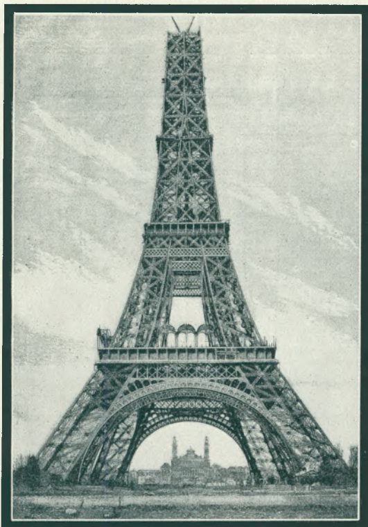
Der Eiffelturm im Bau.
