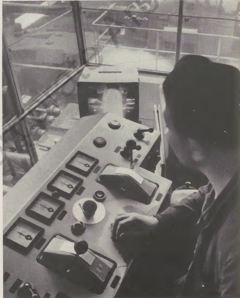
Leitstand des 4,2-m-Quarto-Walzwerks (Inbetriebnahme 1956)
