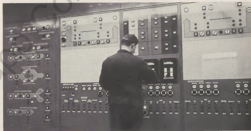
▲ 1. Kellergeschoß: Leitstand der „Haustechnik“ und Pumpensystem der Hochdruck-Klimaanlage
