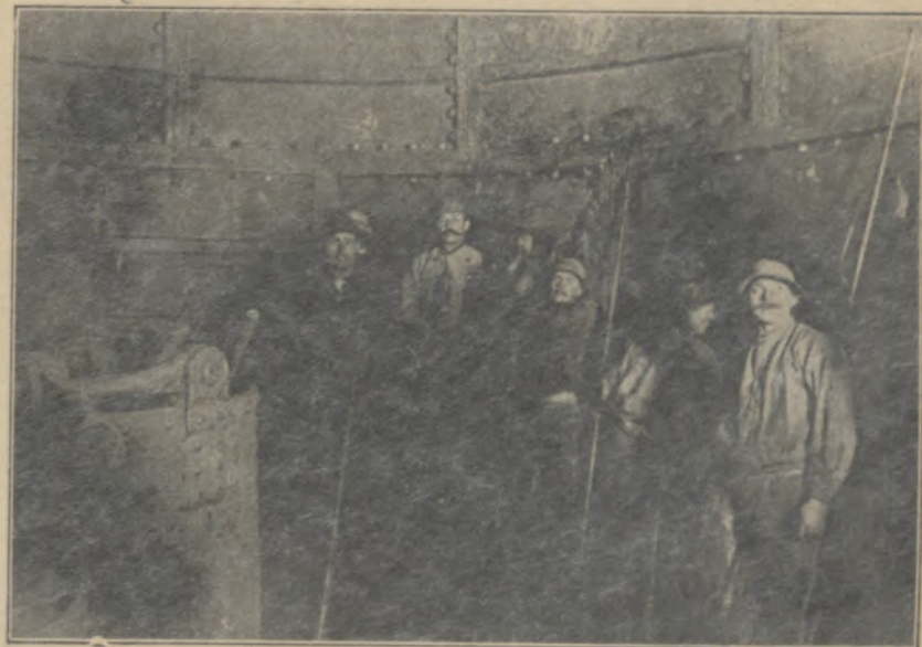
Beim Abdichten der Schachtverkleidung.
