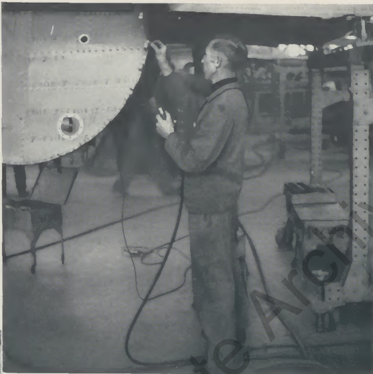
Bild oben: Der dichte Farbdunst, der beim Arbeiten mit der Spritzpistole die Werkstätten der Malerei einhüllt, verlangt eine zweckmäßige Schutzkleidung, deren ordentliche Beschaffenheit für den Mann auf dem Bilde spricht
