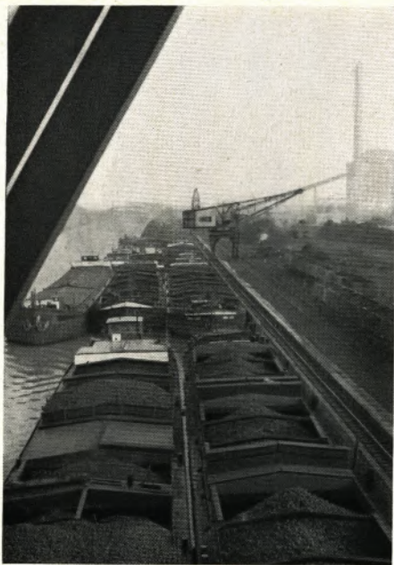
In langer Reihe liegen im Hafen der Altenessener Bergwerks-AG die Kohlenkähne der Hoesch Reederei und Kohlenhandel GmbH. Im Hintergrund rechts das Gebäude des neuen Kraftwerks der Altenessener Bergwerks-AG, über das wir in einem der nächsten Hefte berichten.
