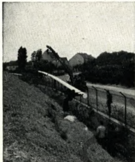
Die erste Sauerstoffleitung mit längsnahtgeschweißten Rohren wird zwischen unseren Werken Ruhrort und Mülheim verlegt S. 15—17
