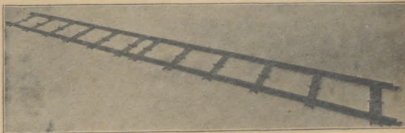
Bild 3: Fertig verlegtes Gleis.
