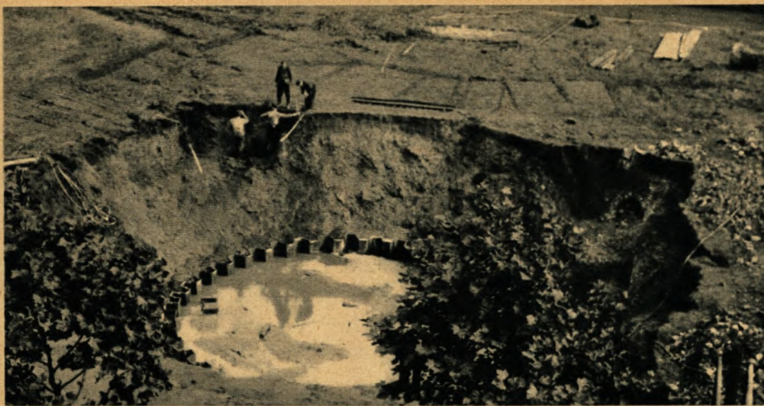
◀ Die Rammarbeiten am sogenannten „Spundschacht“ sind beendet. Die Spundwand reicht von 3 bis 10,50 Meter Tiefe
