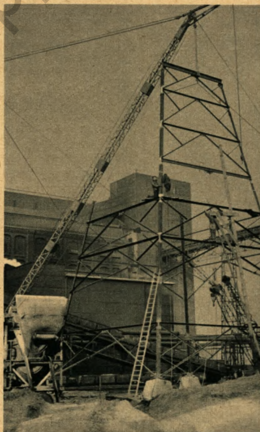
► Das vorläufige Schachtgerüst erhebt sich über dem Schachtring
