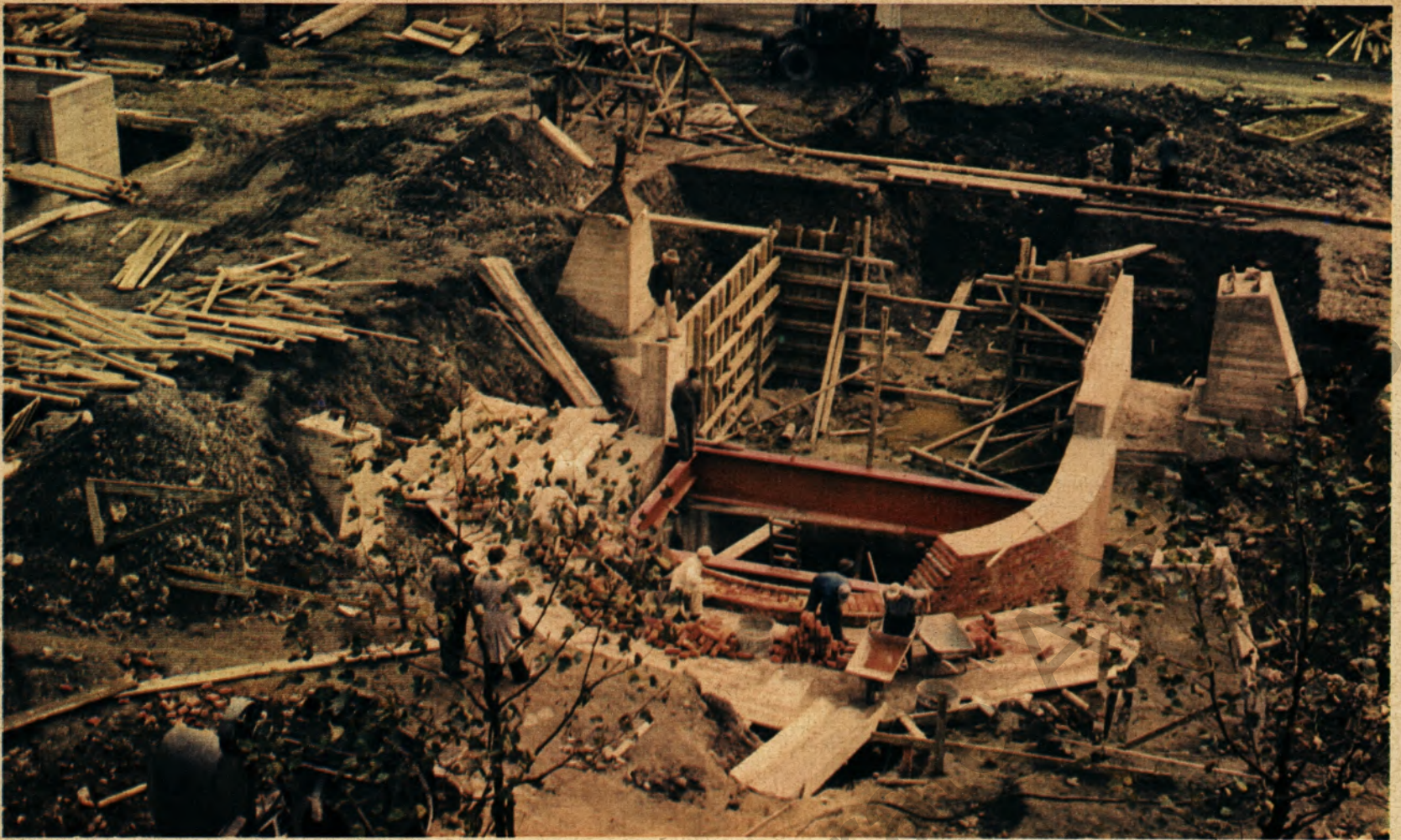
▲ Auf der Altenessener Schachtanlage Fritz-Heinrich werden der Schachtring und die Fundamente für das Schachtgerüst fertiggestellt
