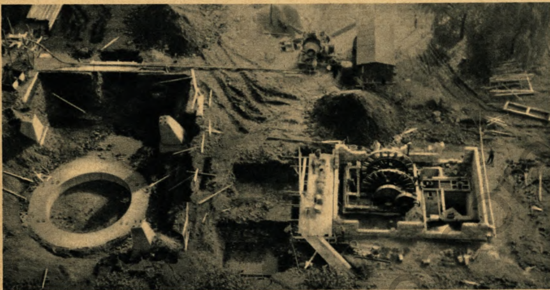
◀ Die Fundamente für das Schachtgerüst werden rund um den Schachtring fertiggestellt (links); rechts erheben sich die Fundamente einer Abteuf-Fördermaschine
