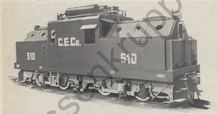
Bild 36 Elektrische Bo'Bo'-Lokomotive für die Chile Exploration Co. für Oberleitungs- und Akkumulatorbetrieb
