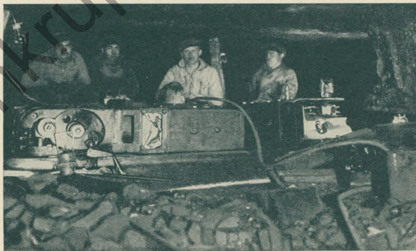
Die elektrisch betriebene Schrämmaschine. Die Bedienungsmannschaft besteht aus einem Europäer (der zweite von rechts) und drei Grönländern.
