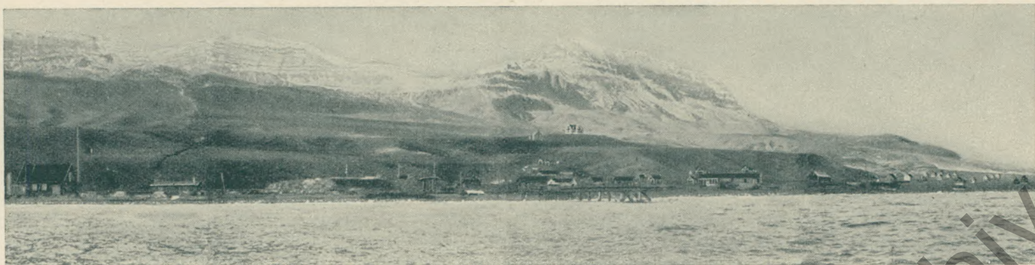
↑ Maschinenhaus ↑ Halde ↑ Stolleneingang ↑ Betriebsführer- wohnung ↑ Verlade- brücke ↑ Kauf- und Vorratshaus ↑ Belegstoffs- siedlung Panorama der Kohlenmine Rudlissat auf der Insel Disko mit dem Basaltlava-Deckgebirge.
