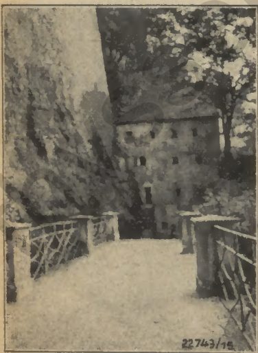
Bild 3: Hohenjalsburg: Brücke über den Festungsgraben
