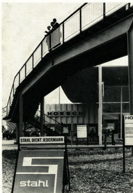
Titelseite: Blickfang und vieldiskutiertes Anwendungsbeispiel für das Bauen mit Normbauteilen aus Bandstahl war auf der Hannover-Messe 1965 die neue Hoesch-Fußgängerbrücke vor unserem Messehaus an der Stahlstraße
