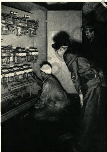
In sechs Lehrgängen bilden sich Hoesch-Bergleute weiter: sie werden Grubenschlosser oder Zechenelektriker. Die Rückseite des Heftes zeigt Johann Göller unter Anleitung von Steiger Gütler bei der praktischen Ausbildung unter Tage. Rechts Elektriker Becker.
