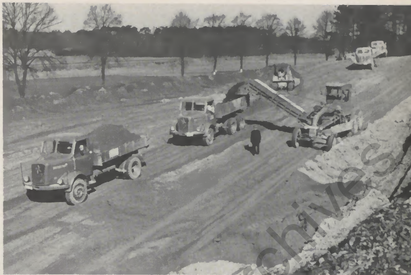
Abb. 6 Ein neuartiges Abraum-Fördergerät „Grader“ mit Seitenlader. Die Erde wird seitlich pflugscharähnlich mit Schaufeln abgetragen und gleichzeitig auf das Förderband gebracht
