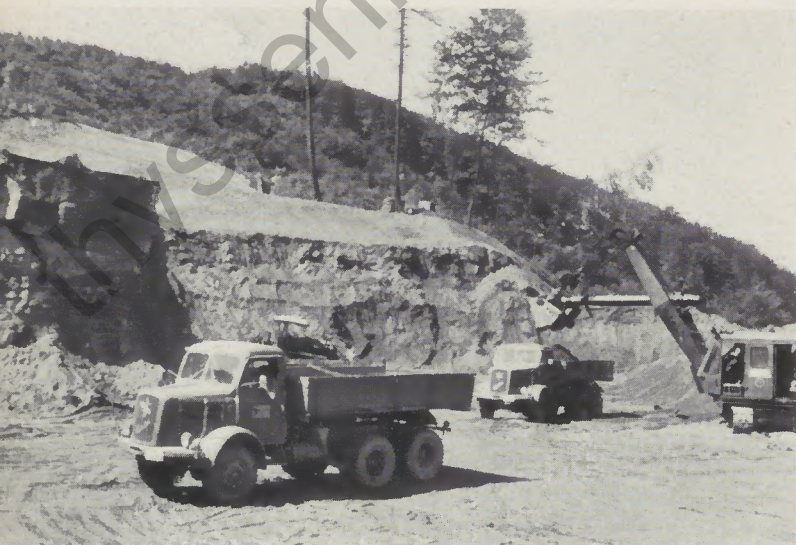
Abb. 5 Beladen der Fahrzeuge auf Terrasse 3. Die Anfahrt hierzu weist eine Steigung von 40 % auf
