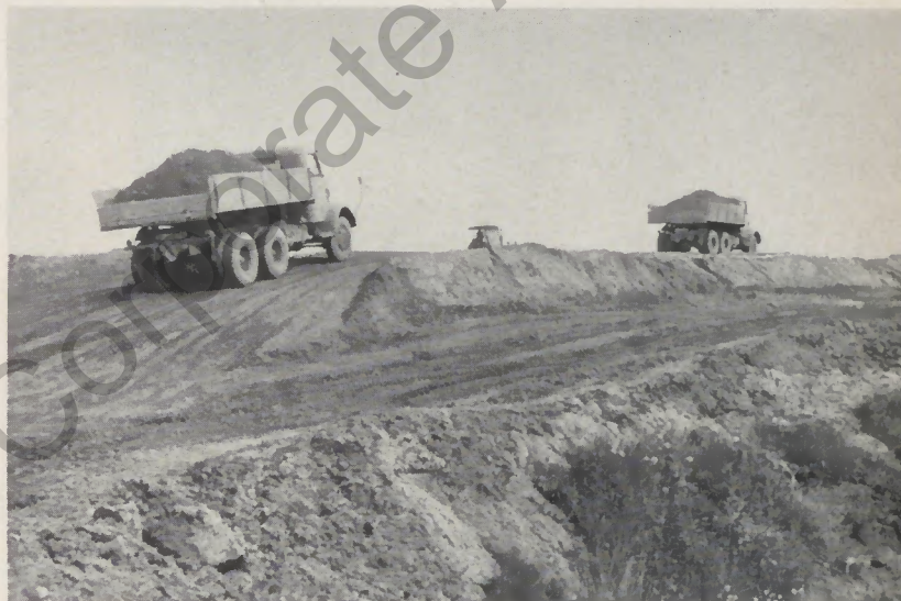
Abb. 7 Auffahrt über den geschütteten Damm zur Trasse
