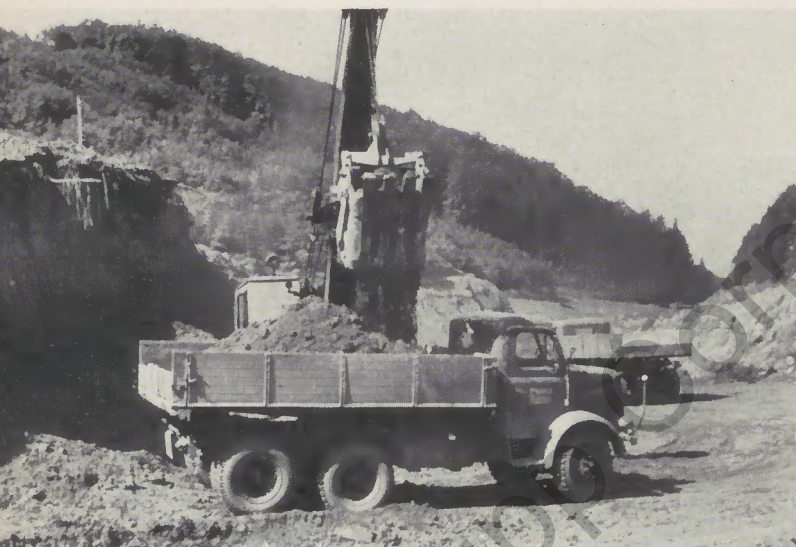
Abb. 4 Beladen der Henschel HS 3-125 mittels Löffelbagger auf Terrasse 2
