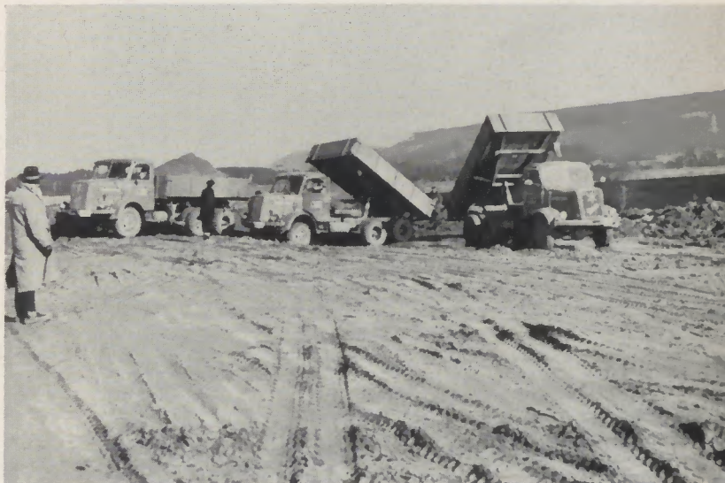
Abb. 8 Entladen der HS 3-125 Allrad-Kipper auf der Trasse der Baustelle
