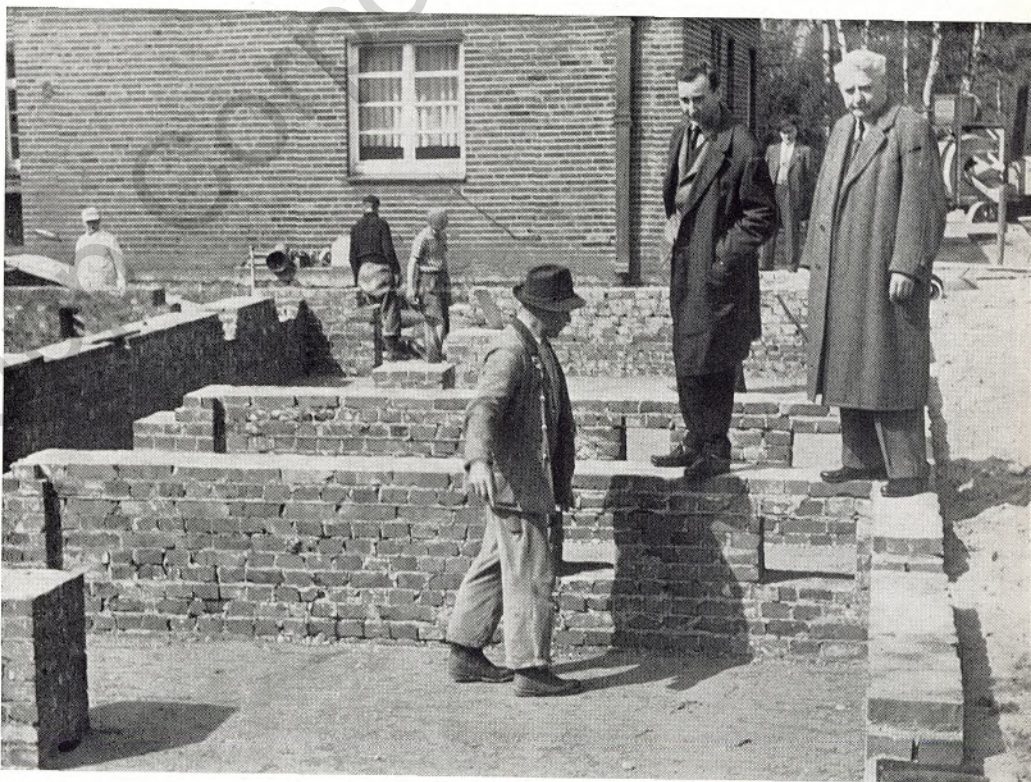
Architekt Hertling (Mitte) und Polier Hüning (links) erläutern Arbeitsdirektor Meyer bei einer Besichtigung der Baustelle die bisher geleisteten Bauarbeiten am Erweiterungsbau des Gästehauses
