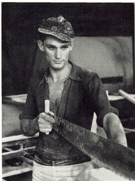
Siporex kann man mit einer gewöhnlichen Holzsäge in Stücke zerschneiden
