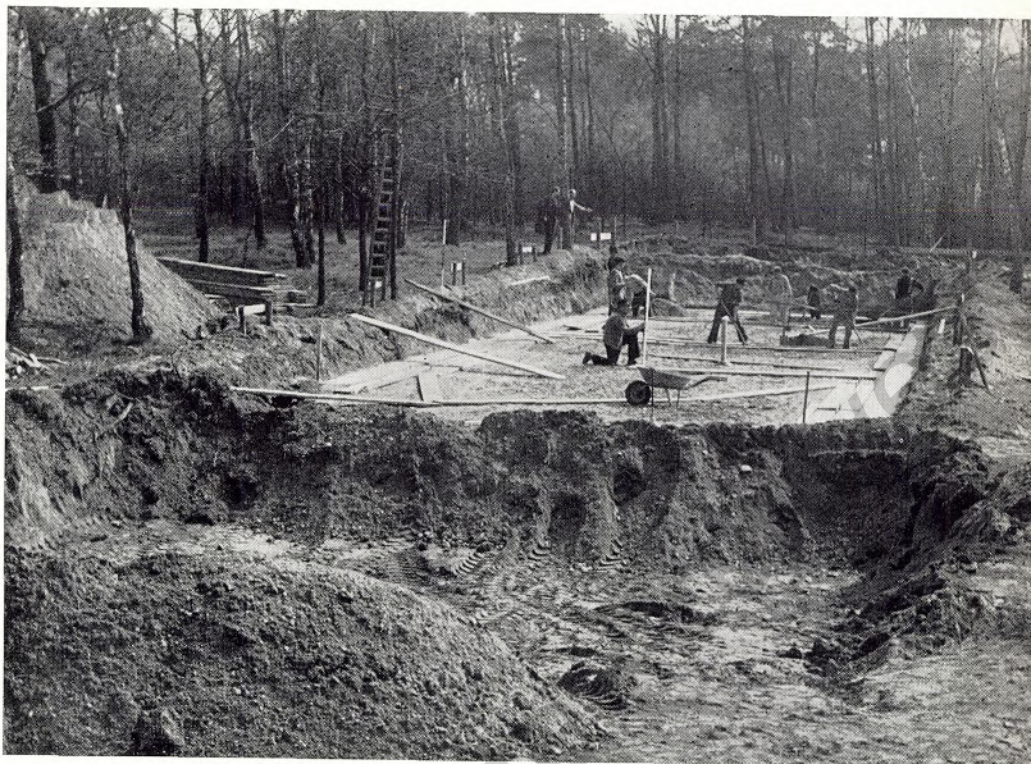
Inmitten der schönen Birken-, Tannen- und Buchenwäldungen entsteht das neue Lehrlingshaus des „Anita-Thyssen-Heimes“ unserer Hütte in Tester Berge
