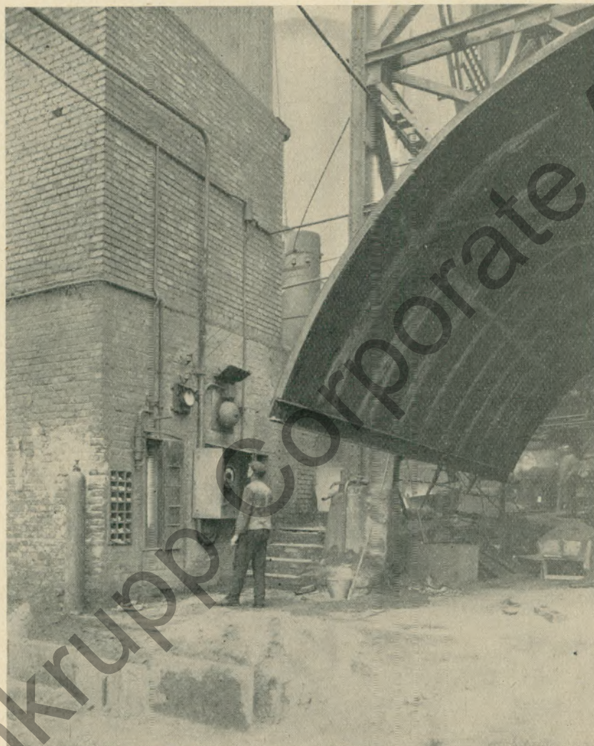
Abb. 4. CO 2 -Anzeige-Instrument zur Bestimmung des Kohlenäuregehaltes im Hochofengas am Kommandoplatz eines Hochofens. (Zum Aufsatz auf Seite 97 bis 100)
