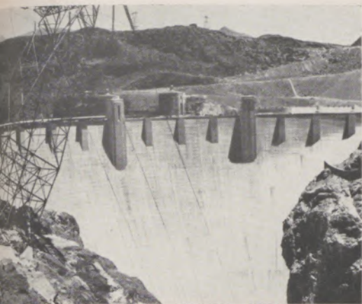
Bild 2 Teil der Staumauer am Hooverdamm
