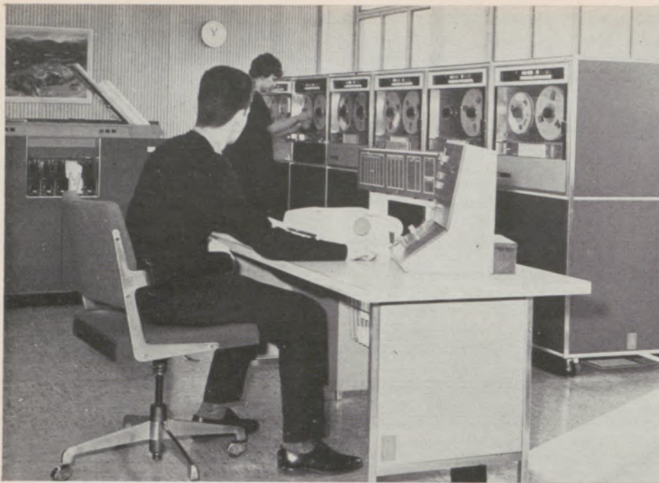
Unsere Mitarbeiterin Irmgard Röhlen beim Einlegen eines Bandes; im Vordergrund unser Mitarbeiter Horst Feld am Steuerpult. Im Hintergrund ist die Kartenabföhl- und Stanzeinheit sichtbar. Diese Maschine kann pro Stunde 48 000 Karten abföhlen und 15 000 Karten stanzen.
