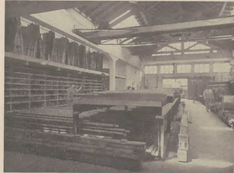
Zürich Teil-Innenansicht des Edelstahlagers
