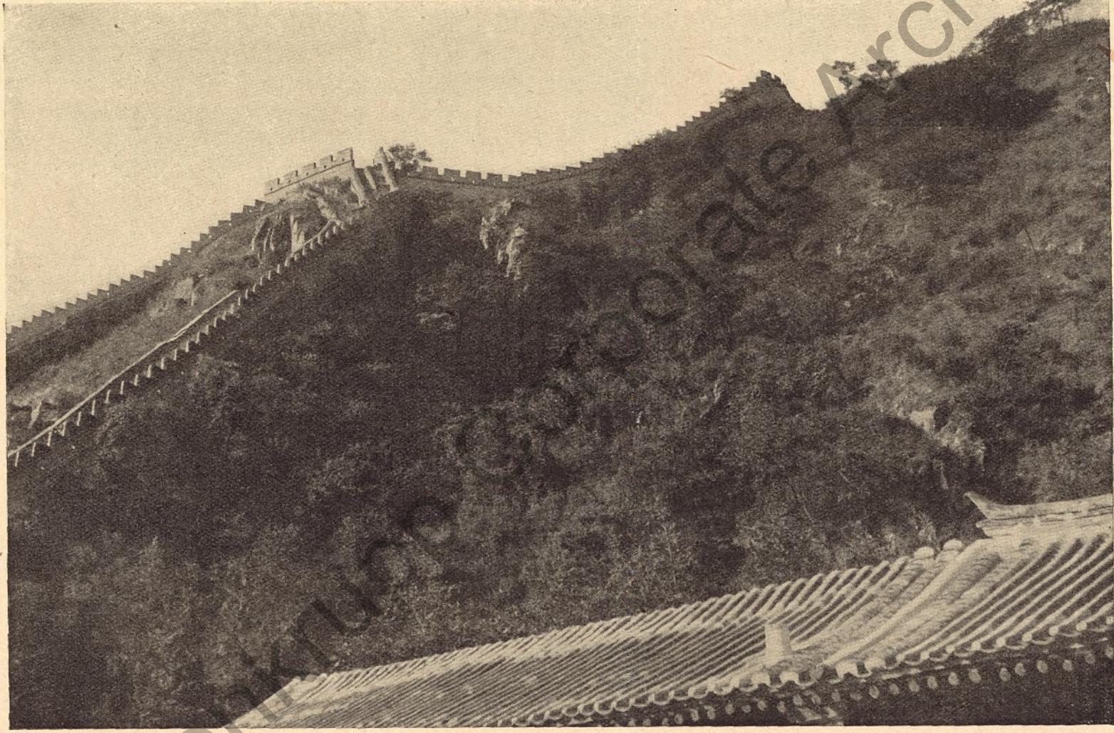
Äußere Ansicht der großen Mauer am Nankon-Paß mit den eigentümlichen Zinnenkränzen und Schießscharten
