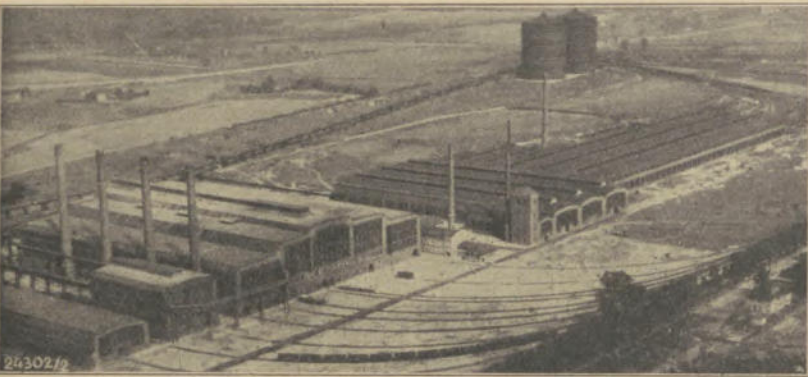
Martinstahlwerk und Röhrenwalzwerk Höntrop des Bochumer Vereins, das modernste Röhrenwalzwerk der Welt
