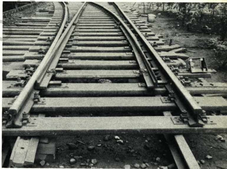
So wurde eine einfache Weiche von der Rotte der Bahnmeisterei 5 auf Volleisenschwellen seitlich montiert. Hier der Weichenanfang.
