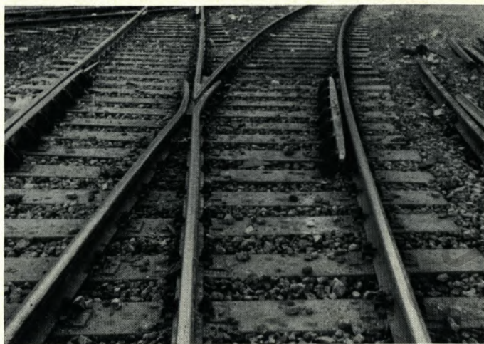
Die fertig verlegte Weiche mit Volleisenschwellen im Herzstück - bzw. Radlenkerbereich,
