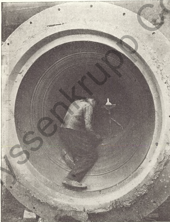
Abb. 4. Inschriften und Verzierungen werden in den Mantel eingeformt
