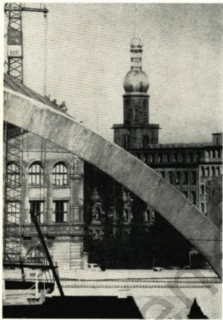
Rückseite: Bei zahlreichen Neubauten öffentlicher Gebäude in den wachsenden Städten im Ruhrgebiet wurde Baumaterial von Hoesch-Werken verwandt. Wir berichteten darüber in Heft 11/1964. Auf unserem Bild fällt der Blick durch einen Stützbogen des Schalendaches für den Zuschauerraum des neuen Stadttheaters in Dortmund. Im Hintergrund die Reinoldikirche
