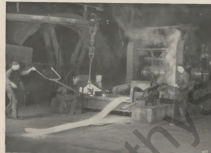
Abb. 3: Auswalzen von Platinen auf einem Trio
