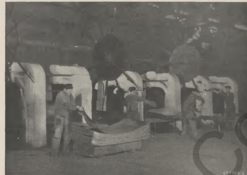
Abb. 5: Links: Dressierwalze; rechts: Kühlwalzen
