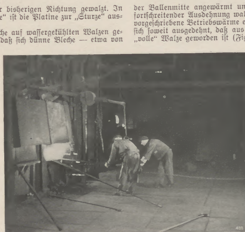
Abb. 9: Stofsofen während des Ziehens eines Blockes
