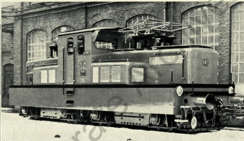
Fertige Lokomotive vor der Überführung nach Oberhausen West. Die Lokomotiven fahren die Bundesbahnstrecke von Kirchen a. d. Sieg nach Oberhausen mit eigener Kraft (mit dem Hilfsantrieb).
